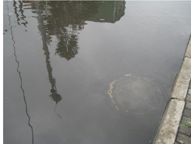
Figura 6-28. Detalle de alcantarilla, visita punto 1
