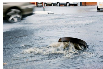
Figura 5-40. Ejemplo de inundación urbana por colmatación de pozos. Fuente: CHI, 2015.
