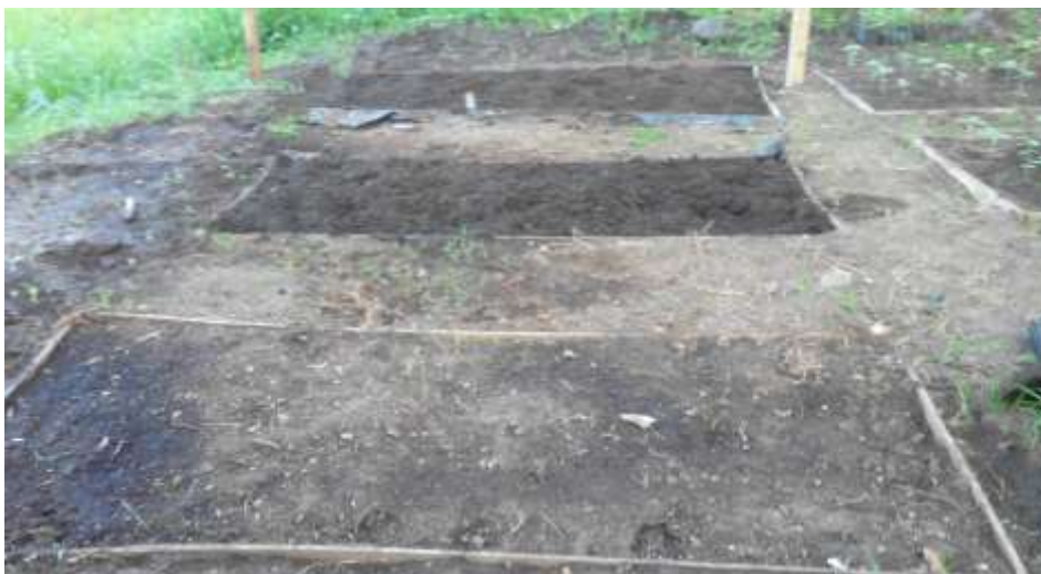
Foto 2. Diseño final unidad de tratamiento de lechos (UTL)
