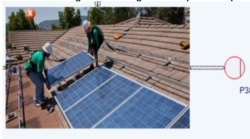
(G) Instalación y montaje de los paneles
