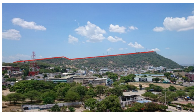
Figura 5. Cerro La Popa con su pendiente noroeste. Observar un escalón debido a una falla normal.
