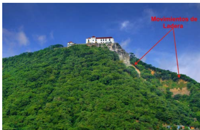
Figura 4. Cerro La Popa con su pendiente con la mayor declividad. Observar movimientos de ladera.
