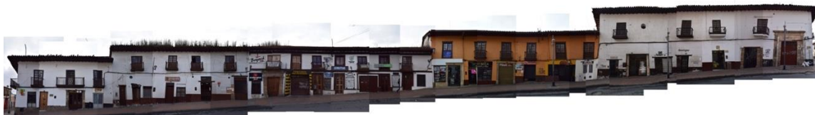
Figura 5-11: levantamiento fotográfico perfil occidente carrera 10ª entre calles 21 y 22. 2016.
