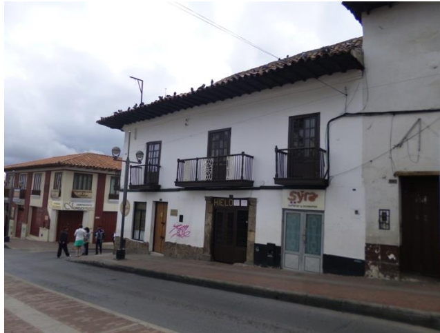
Figura 6-1: casa colonial carrera 10ª calle 22.
