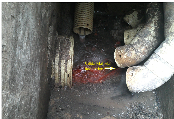
Figura 1.3: Cajilla que conecta con la red de alcantarillado público
