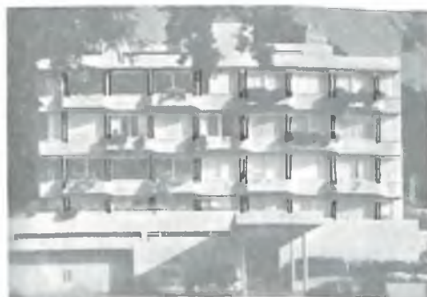
Avenida 82. Estructura manifiesta al exterior.
