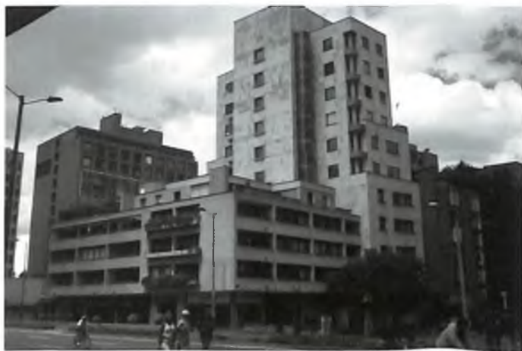
Edificio Rueda y Anexo. Imagen actual. Foto: Camilo Mejía.
