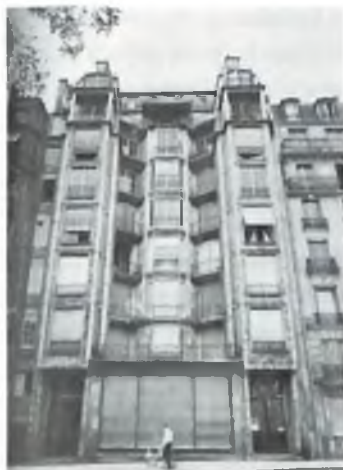
Edificio en la Rue Franklin. Auguste Perret. Izquierda: Vista de fachada. Derecha: Planta tipo.
