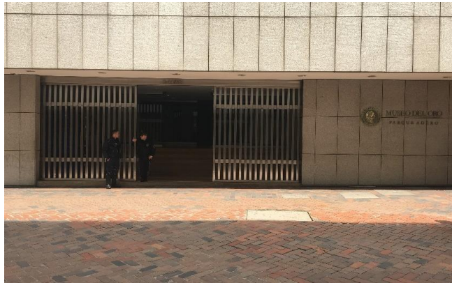
Fotografía 17. Acceso peatonal del Parqueadero.
