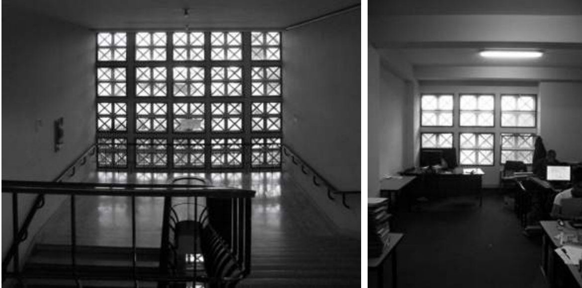
Figura 230 y Figura 231. Con la escalera constreñida entre los muros, la cantidad de luz que ingresa al centro se reduce considerablemente. Por otra parte, las oficinas que avaramente le obligaron a añadir a los costados carecen de condiciones de habitabilidad adecuadas.
