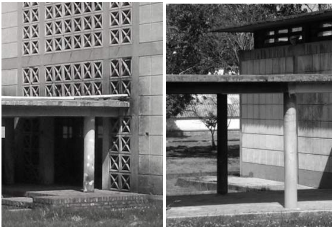
Figura 223 y Figura 224. Las pérgolas encajan con rigor en el sistema modular de calados de los extremos de la fachada frontal. Los volúmenes anexos, más altos, expresan su autonomía respecto a las pérgolas.
