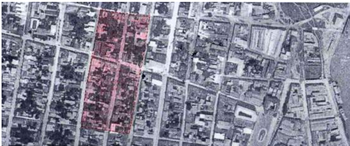
Figura 27. Fotografía aérea del área del proyecto antes de la demolición. Vuelo 81-0102. Octubre 16 de 1937. IGAC.
