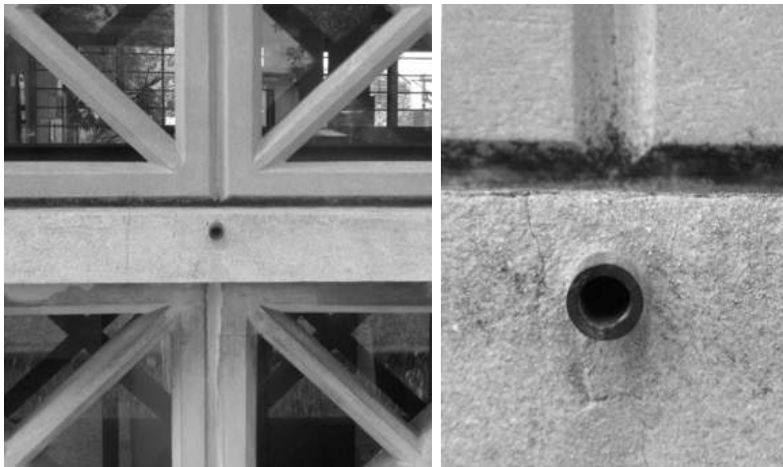
Figura 232 y Figura 233 Detalle de la tectónica de los calados prefabricados y de las venas de concreto que los soportan.
