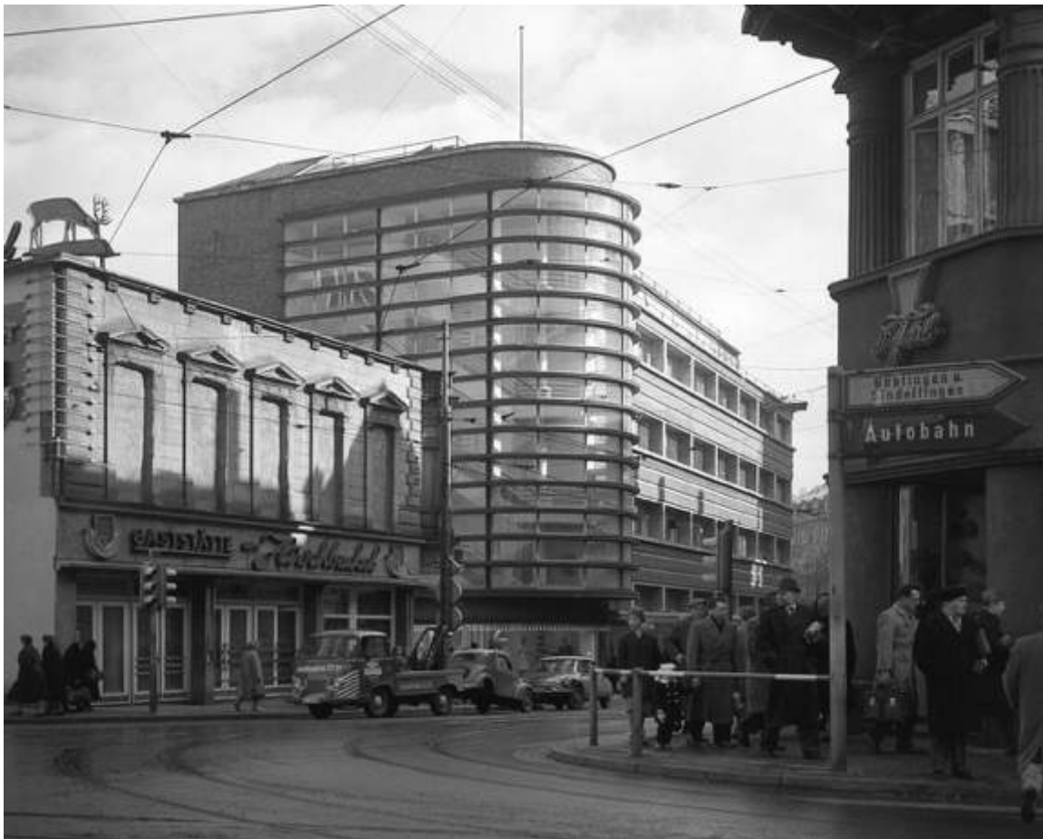
Figura 353. La esquina de los almacenes Schocken, proyectados entre 1926 y 1928, realizada por la caja de las escaleras. El edificio fue demolido en los años sesenta. (Fotografía de Manfred Niermann.)
