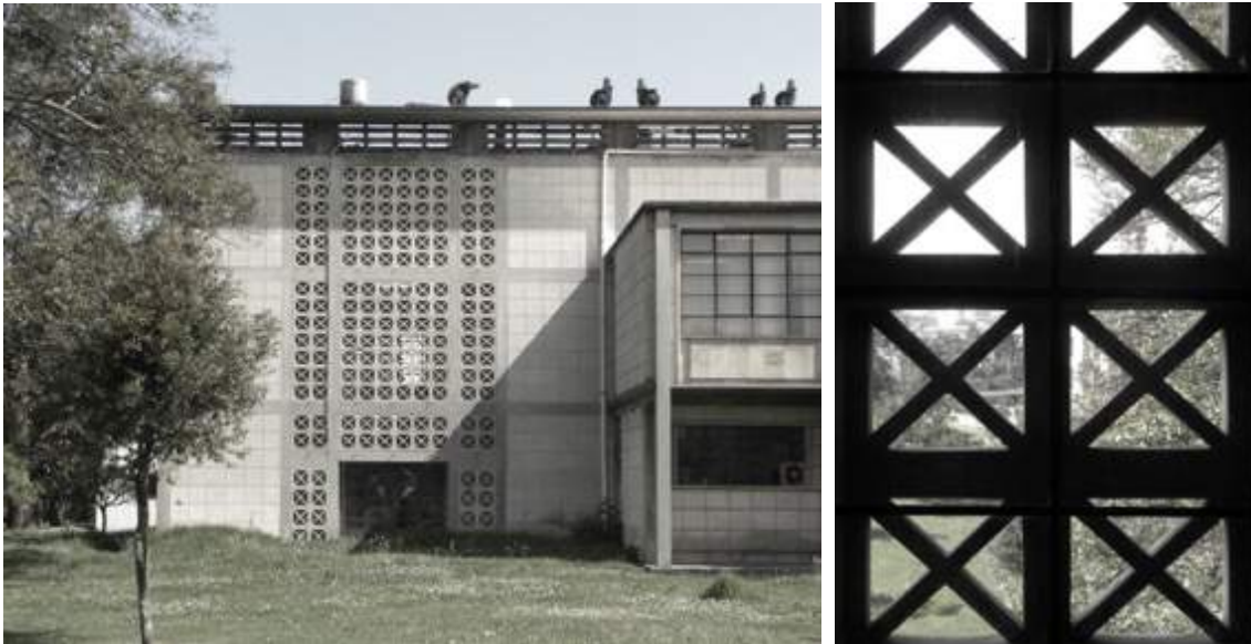
Figura 222. Ensanchamiento del intercolumnio central con dos columnas que enmarcan los calados y resuelven la articulación de las pérgolas, que así adquieren una sección más delgada. A la altura del dintel de la puerta aparece una viga de la altura de una franja de piezas prefabricadas, destinada a recibir la pérgola, que en esta ala jamás se construiría. A la derecha, vista del paisaje del campus a través de los calados. Fotografías de MPA.
