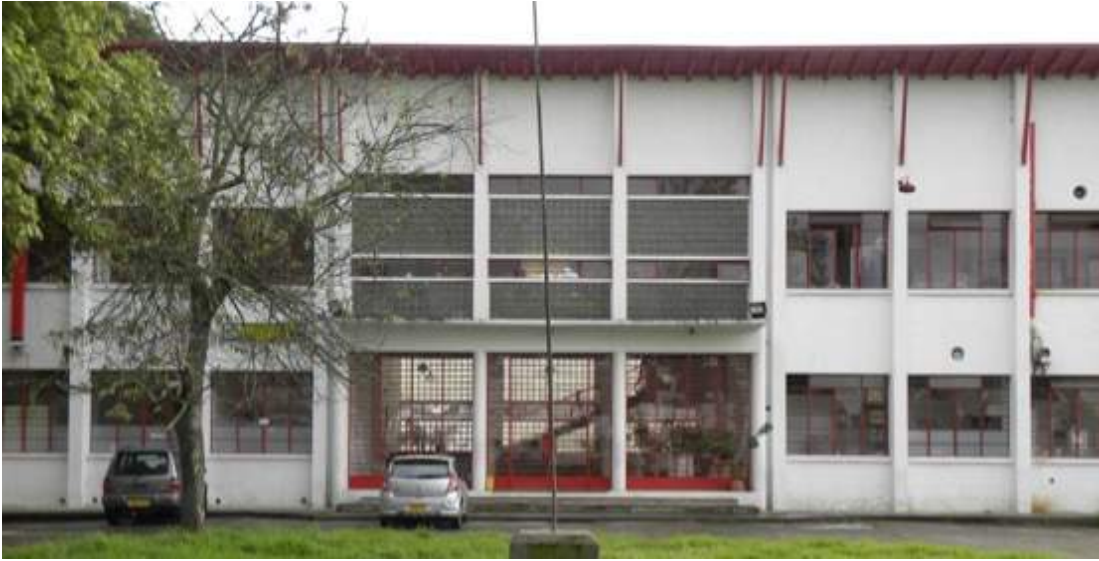
Figura 196. Fachada actual del Instituto de Ciencias Veterinarias, con las ventanas horizontales de la biblioteca a la altura de los ojos de los lectores sentados. Las juntas de construcción a lado y lado del vestíbulo realzan el valor del cuerpo central. (Foto MPA.)
