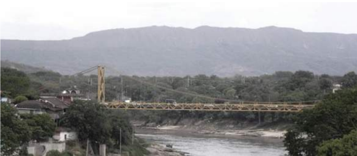
Figura 386. Girardot. Puente para automotores, sobre el Río Magdalena. (Fotografía de MPA.)
