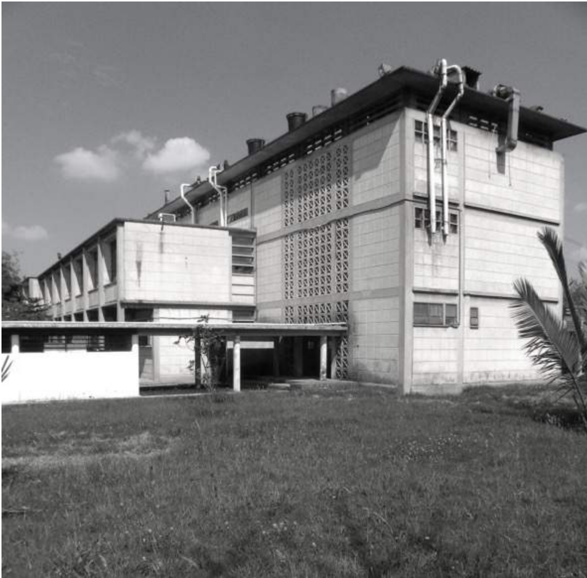
Figura 219. La nave anterior se separa de las otras dos acortándose, reduciendo su altura en un piso y mediante la franja vertical de cristal que Rother sitúa en el encuentro de las dos cajas. (Foto de MPA.)
