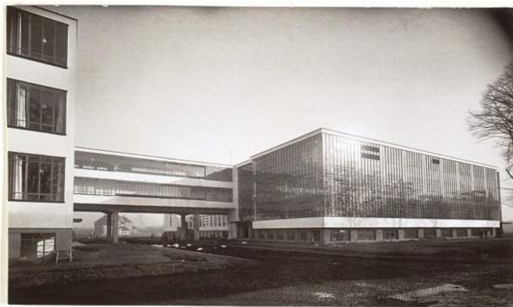
Figura 85. Fotograf a de los bloques de la Bauhaus unidos, por el puente de la direcci n. Lucia Moholy. 1926.
