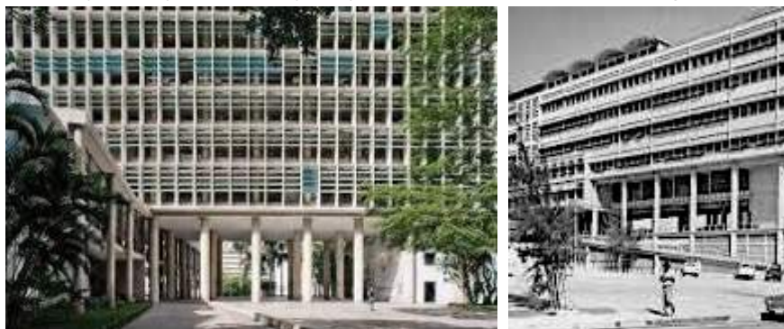
Figura 318 y Figura 319 Vista de los pórticos de gran escala del Ministerio de Educación y Salud Pública y del Edificio Nacional. Configuran en ambos casos un espacio de recepción abierto a la ciudad, accesible por sus dos caras. Son a su vez, el preámbulo de la llegada del público y de los funcionarios a sus respectivos núcleos de circulación vertical, situados en los extremos de los prismas superiores.
