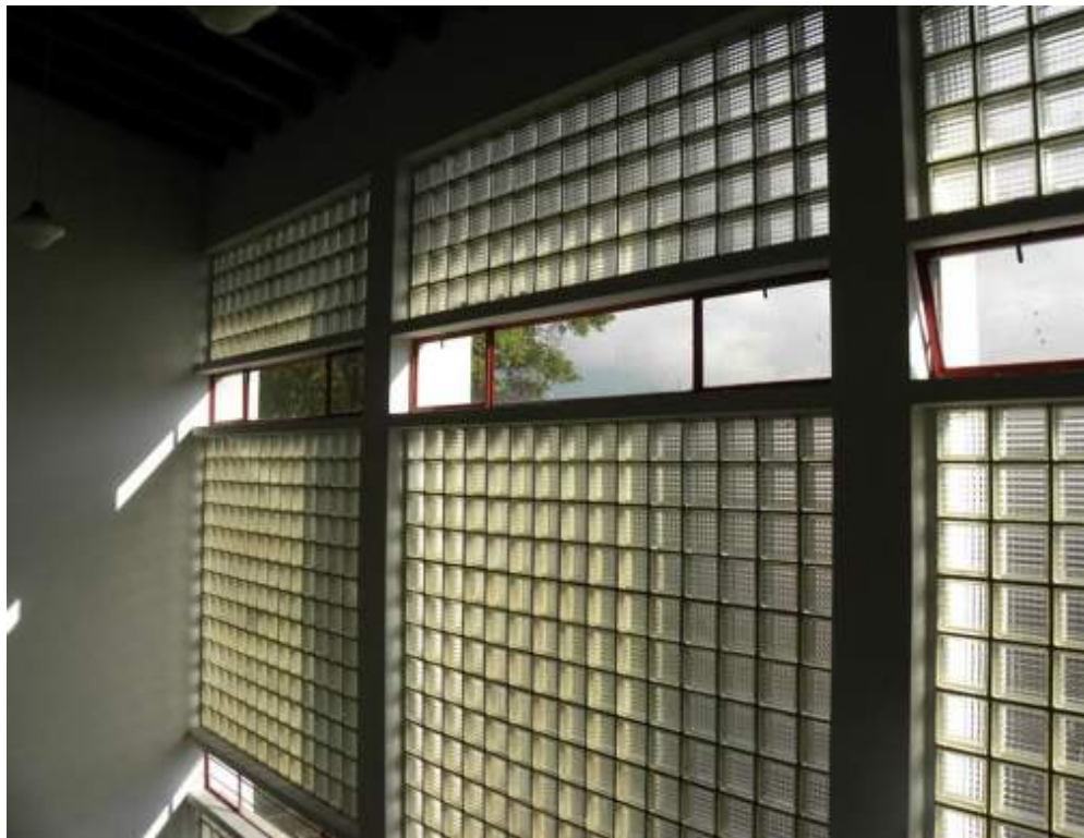
Figura 194. Pared posterior del vest bulo del edificio del Instituto de Ciencias Veterinarias, construida enteramente con bloques de vidrio y con ventanas horizontales transparentes que permiten ver la vegetaci n del campus y tambi n, al descender por la escalera, los cerros orientales. (Foto MPA.)
