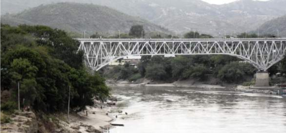
Figura 385. Girardot. Puente del ferrocarril, sobre el Río Magdalena. (Fotografía de MPA.)
