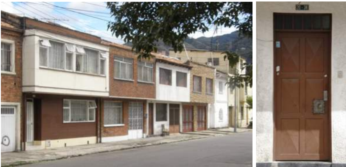
Figura 166 y Figura 167. La casa de la familia Rother correspondía al número 20-34 de la calle 44. Era la tercera, de izquierda a derecha, de la serie de cuatro unidades que originalmente tenía una apariencia homogénea, similar a la de la segunda casa de izquierda a derecha. El garaje era el archivo donde guardaba sus carpetas. (Fotos MPA.)
