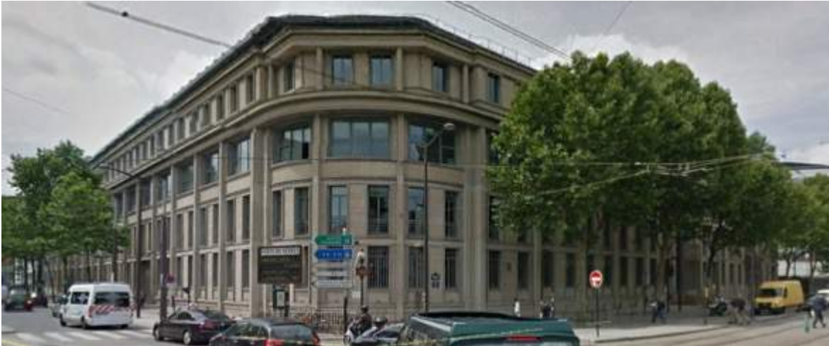
Figura 239. Antiguo edificio del Ministerio de la Marina de Francia, proyectado por Auguste Perret. París. (Google.)
