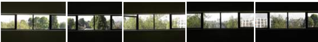
Figura 245. Ensamblaje fotográfico de 5 módulos consecutivos de ventanas del corredor del tercer piso.
