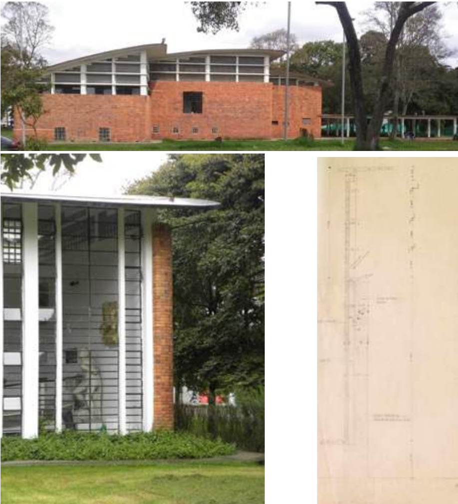
Figura 434, Figura 435, Figura 436. Fachada oriental. Esquina noroccidental. Corte de fachada por el cerramiento. (Archivo General de la Nación. Fondo Invías. Plano no. 2636. Signatura -1, 9, 11, 115. Colección adquirida por el MALR de la Universidad Nacional.)
