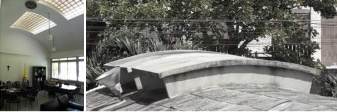
Figura 373 y Figura 374. Imágenes del espacio interior bajo la cubierta y del aspecto exterior de las láminas que sobresalen de ella. El sistema estructural concebido por Rother se modificó en la obra. Lamentablemente, tras la restauración de que fue objeto el edificio en años recientes, los bloques de vidrio fueron colocados obstruyendo las aberturas, cancelando el funcionamiento del sistema de ventilación natural ideado por Rother y restando iluminación al espacio. (Fotografías de MPA.)
