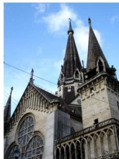
RECONSTRUCCIÓN TORRE DE LA CATEDRAL
