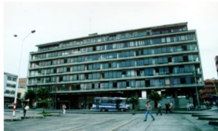
Edificio Antigua Alcaldía Municipal de Manizales - Demolido por la Administración Municipal en el año 2.002
