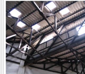
Cerchas planas dentadas de madera pernada. Cubierta en tejas de asbesto cemento con claraboyas en vidrio.
