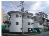
CASA RÍOS - BARRIO ESTRELLA BAHAREQUE ENCEMENTADO DEMOLIDO 2.009
