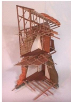
ESTILO TEMBLORERO 2: 1º PISO: TAPIAS DE TIERRA PISADA Y MAMPOSTERÍA DE LADRILLO 2º PISO: BAHAREQUE DE TIERRA
