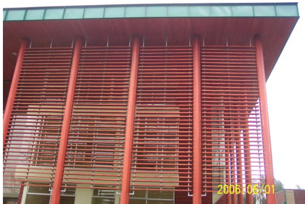
Universidad del Bio-Bio, Concepción, Chile. Facultad de arquitectura, construcción y diseño. Edificio de Diseño.
