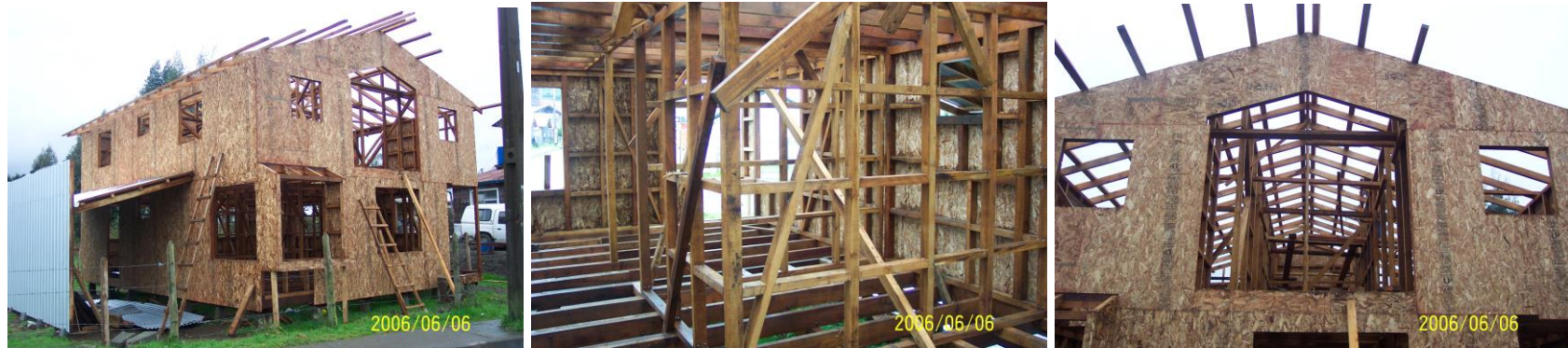
Casa en construcción, Curaco de Vélez, archipiélago de Chiloé, Chile.
