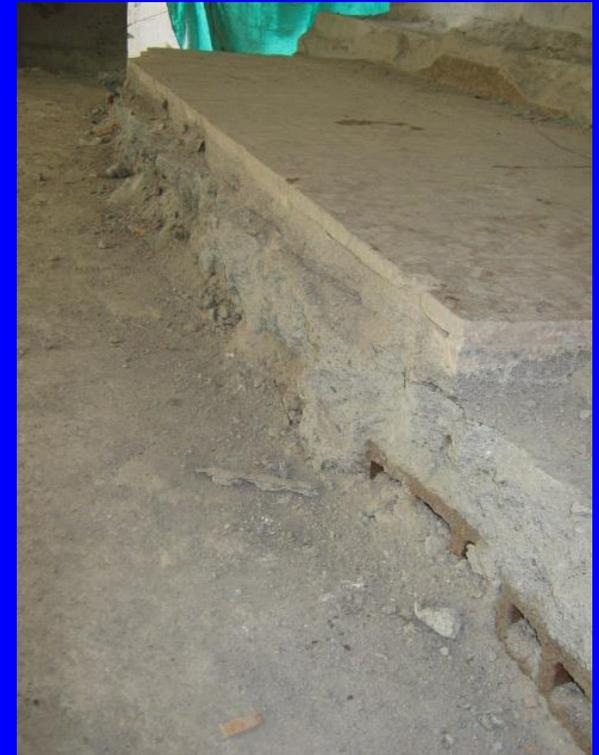
El incremento de 456 millones en este capítulo se debe a la decisión de demoler todos los muros y pisos con el fin de implantar la nueva arquitectura en el edificio y ganar en altura de entrepiso ya que se detectó que había hasta tres acabados de piso uno sobre otro.
