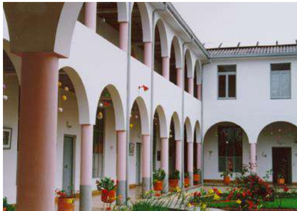
Imagen 51: sistema constructivo ferro concreto moderno, estructuras DOM-INO, edificios de baja altura. Monasterio de la Visitación
