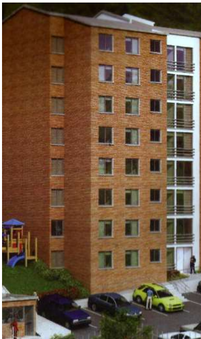
Imagen 86: sistema constructivo mampostería estructural en ladrillo contemporáneo, Edificios en altura. Mirador de la Frontera
