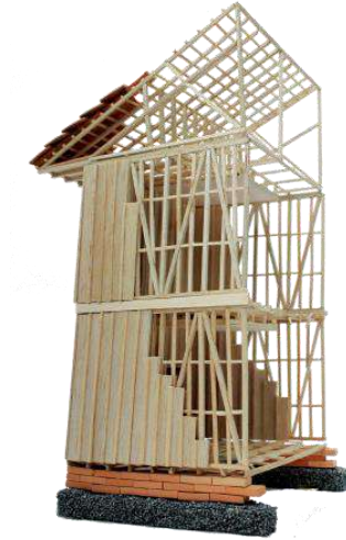
Imagen 12: sistema constructivo bahareque de tabla
