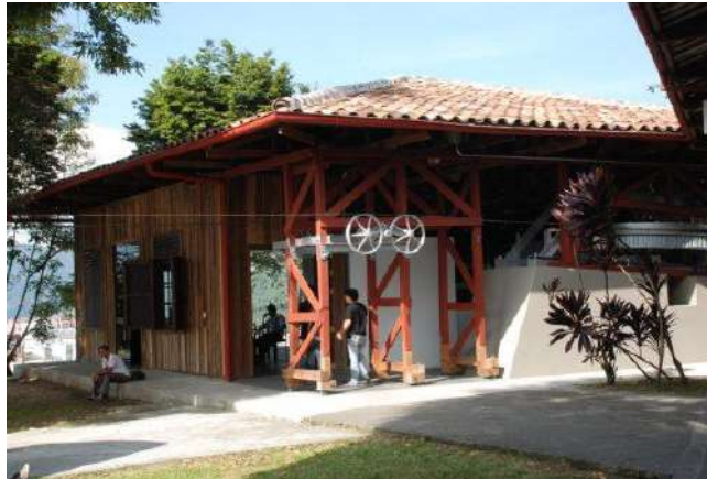
Imagen 21: sistema constructivo madera con uniones emperradas. Sala de Máquinas El Cable
