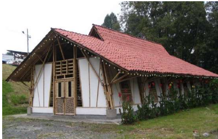
Imagen 87: sistema constructivo guadua con uniones empernadas contemporáneo Sala Conferencias Hospital Santa Sofía
