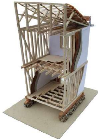
Imagen 14: sistema constructivo bahareque encementado
