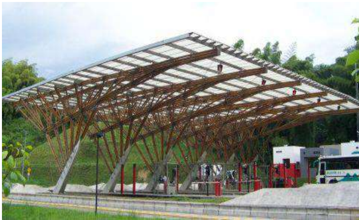
Imagen 89: sistema constructivo guadua High - Tech contemporáneo. Peaje Pavas
