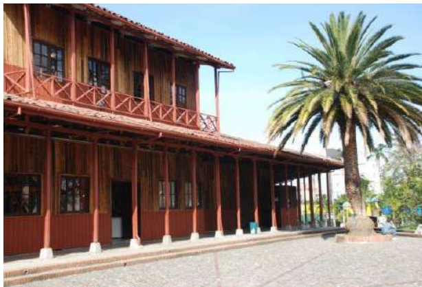
Imagen 22: sistema constructivo madera con uniones empernadas. Bodegas El Cable
