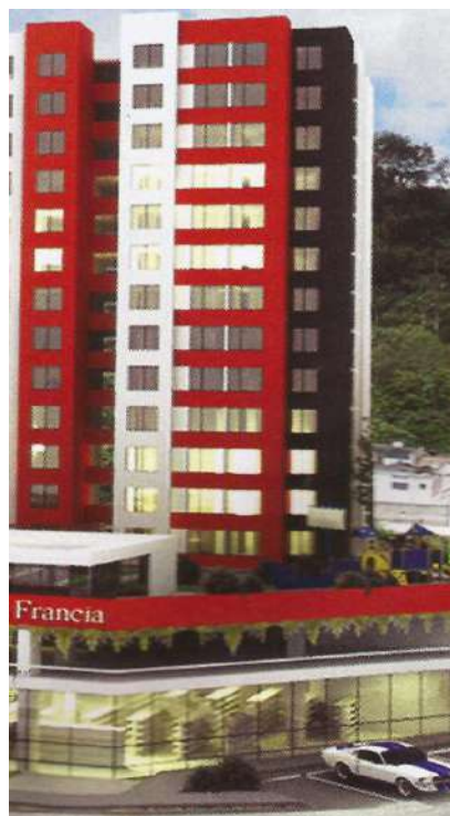
Imagen 85: sistema constructivo muros vaciados en concreto reforzado contemporáneo, edificios en altura con plataforma de transición
