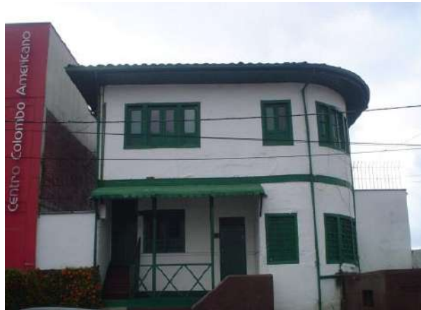
Imagen 42: sistema constructivo bahareque de tierra de transición. Casa Vásquez
