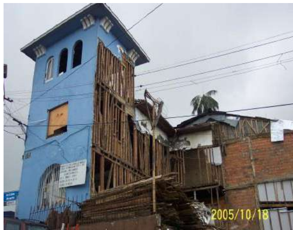
Imagen 41: sistema constructivo bahareque de transición. Clínica Manizales
