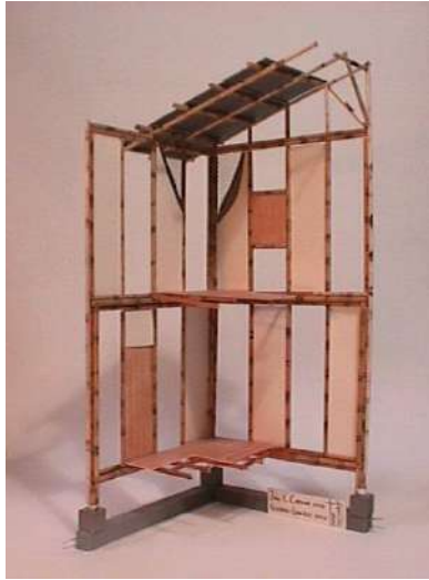
Imagen 77: sistema constructivo guadua con uniones empernadas posmoderno Barrio La Divina Providencia
