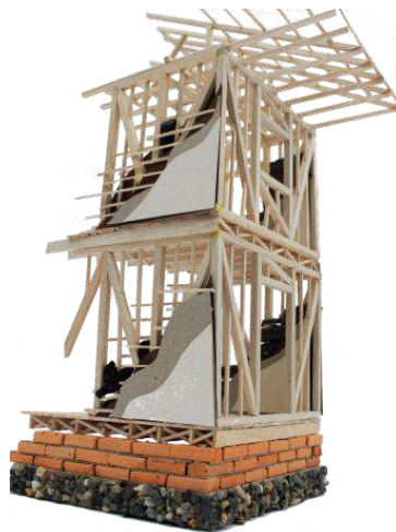
Imagen 11: sistema constructivo bahareque de tierra
