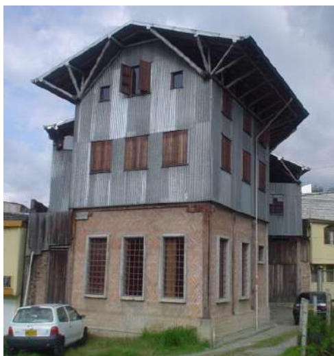
Imagen 82: sistema constructivo temblorero posmoderno. Taller Villegas
