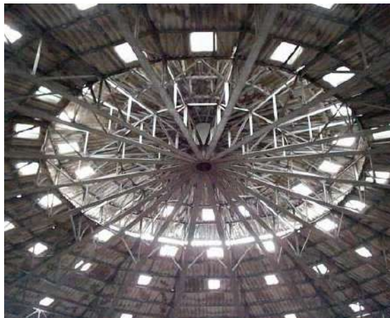
Imagen 48: Sistema constructivo ferro concreto y metálica de transición. Pabellón Central Plaza de Mercado
