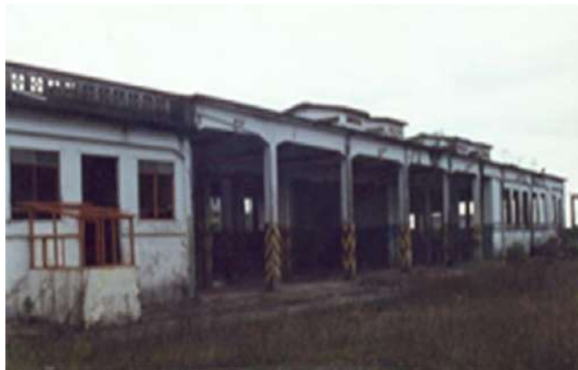
Imagen 23: sistema constructivo cemento armado. Matadero Municipal
