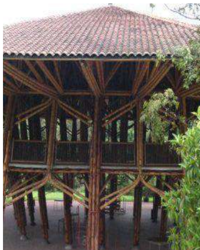
Imagen 78: sistema constructivo madera y guadua con uniones empernadas posmoderno Pabellón ZERI
