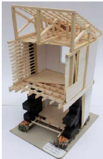
Imagen 7: sistema constructivo estilo temblorero urbano con tapias y bahareque de tierra - T1
