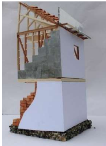
Imagen 9: sistema constructivo estilo temblorero con bahareque metálico
