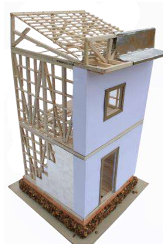
Imagen 13: sistema constructivo bahareque metálico
