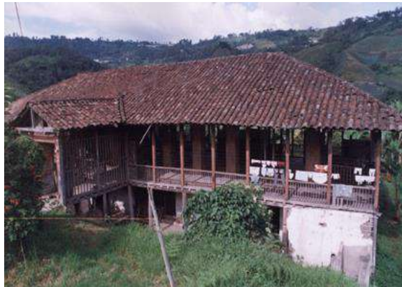
Imagen 8: sistema constructivo estilo temblorero con bahareque de tabla. Trilladora El Arenillo
