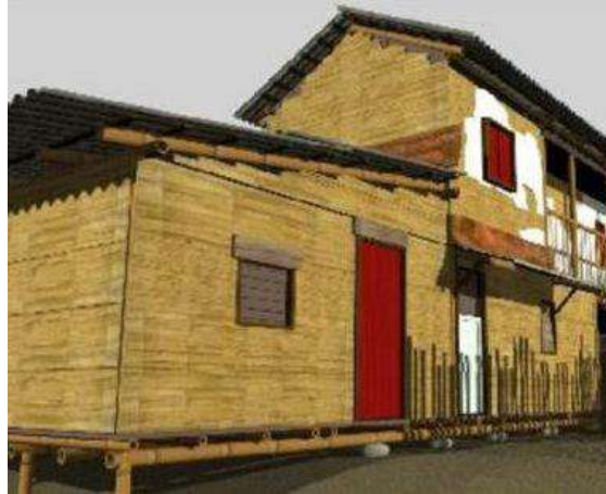
Imagen 43: sistema constructivo bahareque de invasión.
