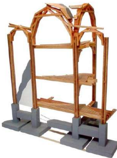
Imagen 76: sistema constructivo madera laminar con uniones empernadas posmoderno Casa Villegas
