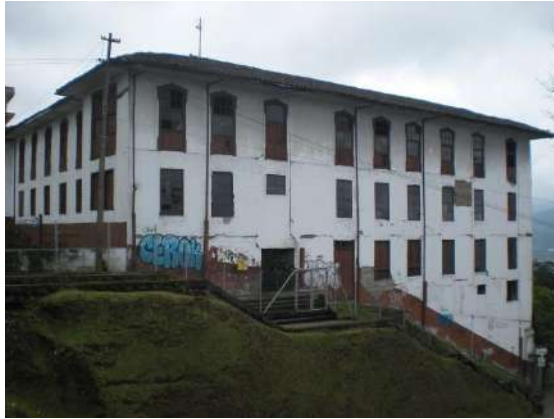
Imagen 16: sistema constructivo bahareque (metálico) - encementado. Colegio Mayor de Caldas
