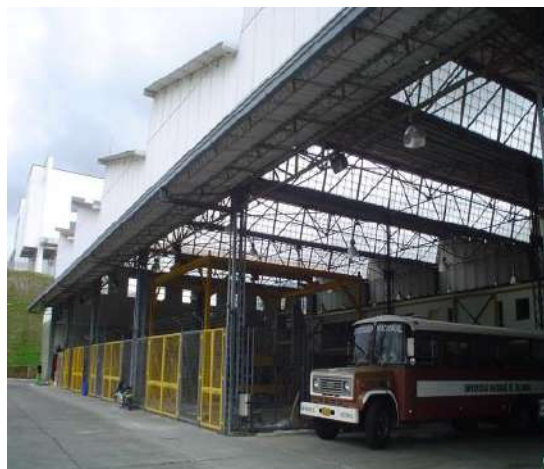
Imagen 62: sistema constructivo pórticos metálicos en celosía, moderno tardío. Talleres – Bloque V
