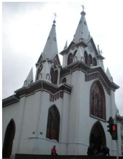
Imagen 15: sistema constructivo bahareque metálico. Iglesia de la Inmaculada
