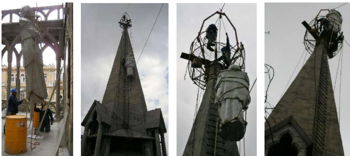
Proceso de izada e instalación escultura san Pablo– torre sur oriental
