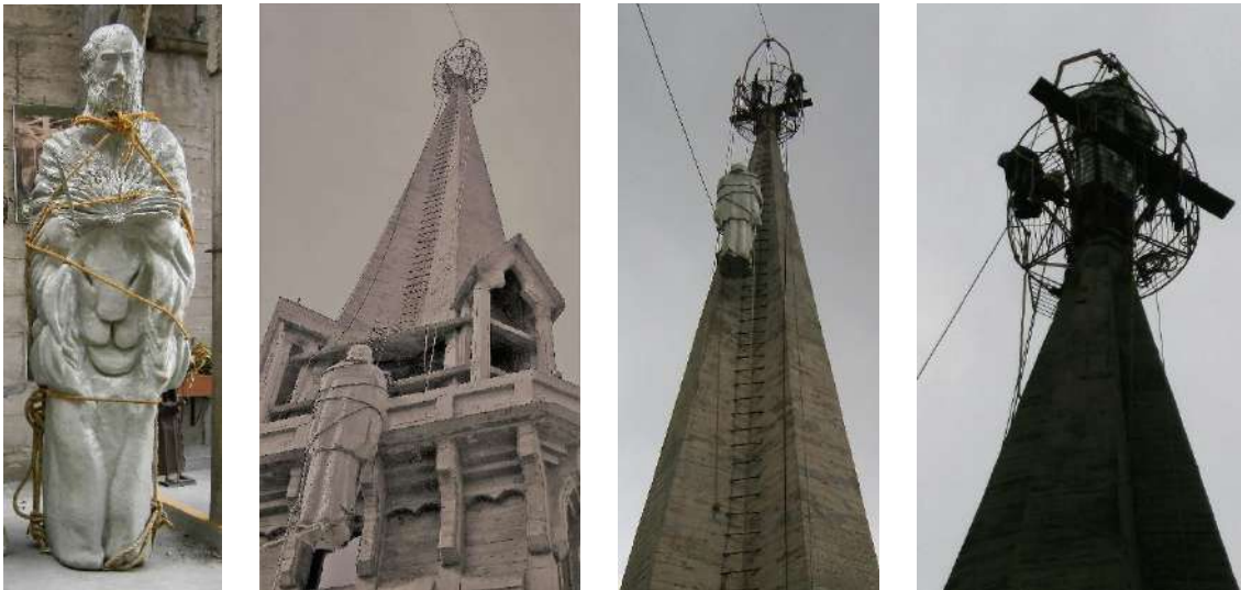
Proceso de izada e instalación escultura san Marcos –Torre nororiental
