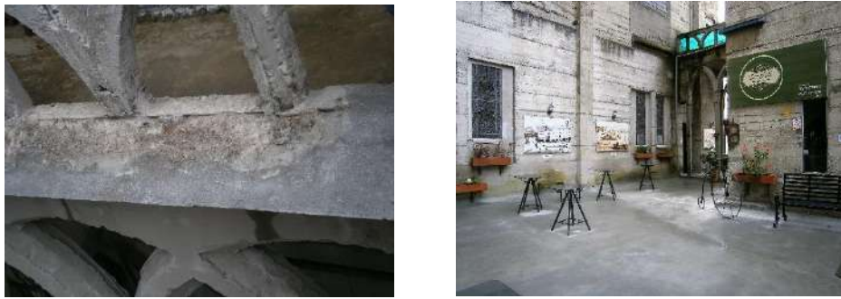
Modelo de resanes de alfajías y morteros de terrazas
