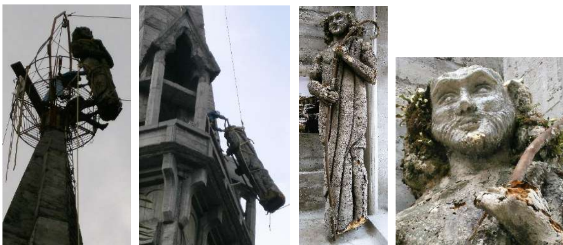
Proceso de desmonte escultura san Juan Bautista - torre noroccidental
