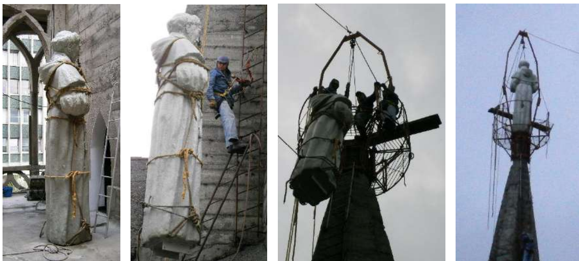
Proceso de izada e instalación escultura san Francisco de Asís – Torre noroccidental
