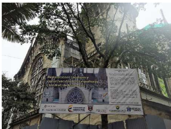
Reubicación Valla de Obra – Carrera 23 Calle 22
