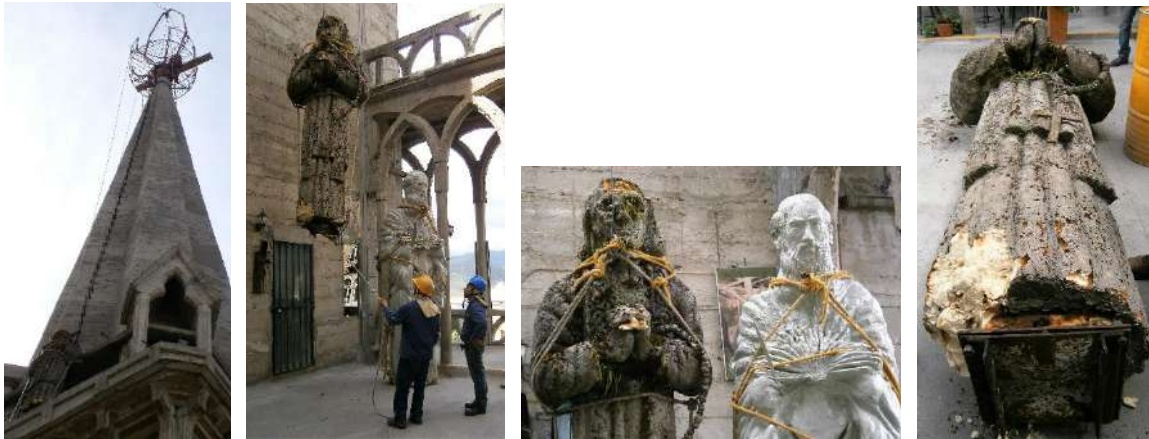
Proceso de desmonte escultura santo Cura de Ars – Torre nororiental
