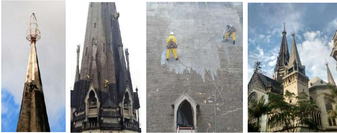
Tratamiento de superficies de concreto en torres y techos Catedral de Manizales
