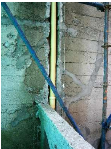
Cajas existentes para bajantes de aguas lluvias a reutilizar
