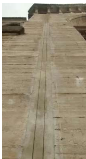
Cajas existentes para bajantes de aguas lluvias a reutilizar
