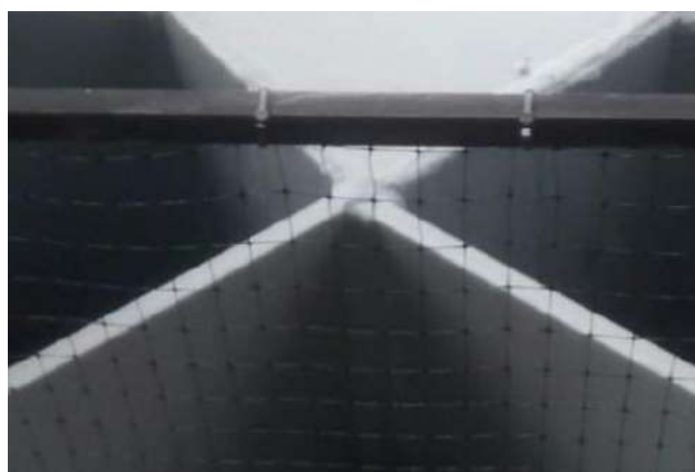
Ventanas de cerramiento de vanos para protección contra palomas y aves
