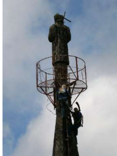
Construcción primera plataforma metálica - Torre sur occidental
