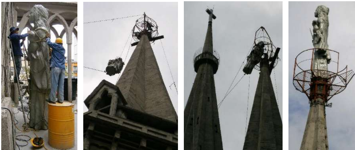
Proceso de izada e instalación escultura santa Inés – torre sur occidental
