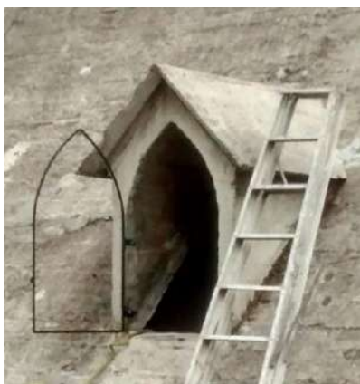
Ventanas de cerramiento de vanos para protección contra palomas y aves
