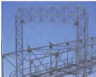
Pórticos, columnas y vigas, en estructura tridimensional de elementos tubulares metálicos con uniones en platinas soldadas y pempadas y tensores metálicos.
