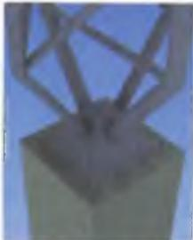
Cimientos en concreto reforzado con dados o pedestales de sobrecimiento los cuales se coronan con las platinas piramidales de transferencia de soporte de los pórticos metálicos.
