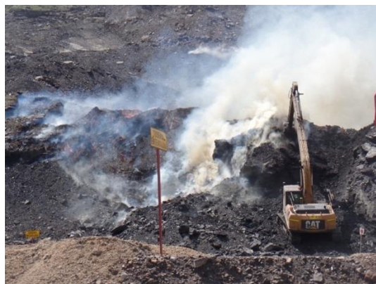
Figura 2-19. Remoción de material caliente en la mina Cerrejón.
