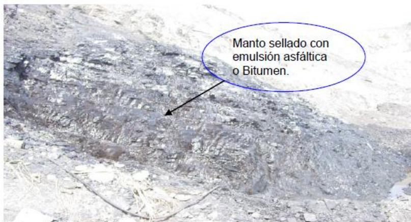
Tal como se puede apreciar en la Figura 5-1, se ha evidenciado que la implementación del bitumen sobre el carbón aísla de manera efectiva el ingreso de oxígeno a los mantos, previniendo la combustión espontánea de carbón, la cual se refleja en los controles realizados luego de que se aplica el producto, donde se evidencia la poca susceptibilidad de incendios sobre las zonas que han sido tratadas con este producto.
