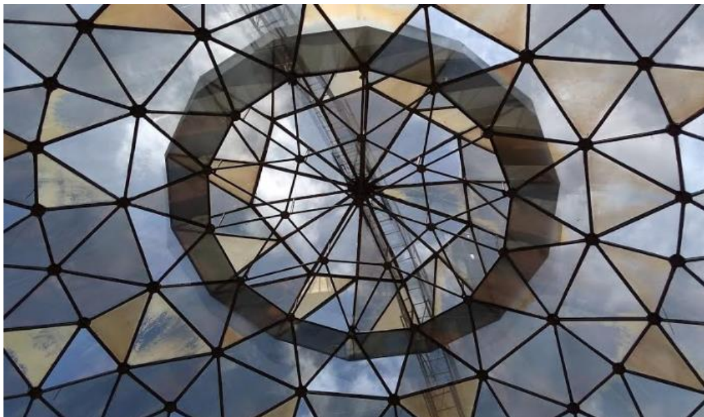
Figura N°5. (Fotografía) Estructura del techo de Unicentro Medellín
