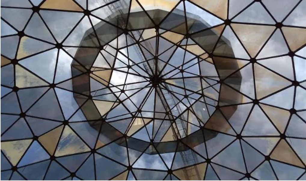
Figura N° 13. (Fotografía) Estructura del techo de Unicentro Medellín
