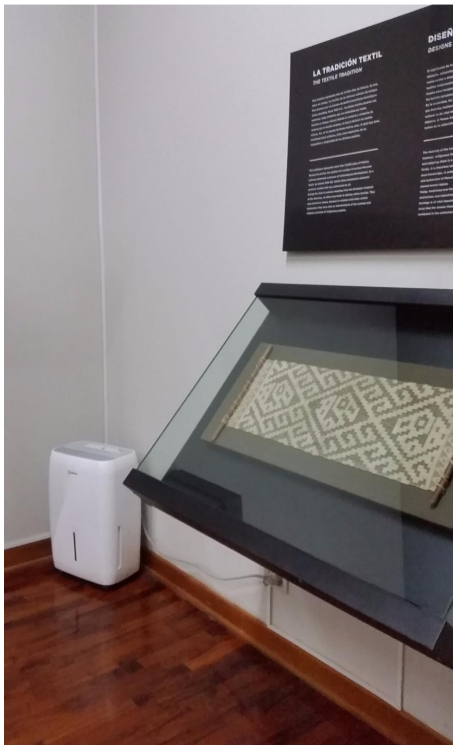
Figura 2-5: Ubicación de deshumidificador en sala.
