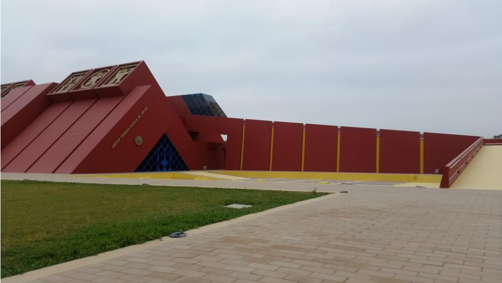
Figura 3-2: Vista frontal del edificio
