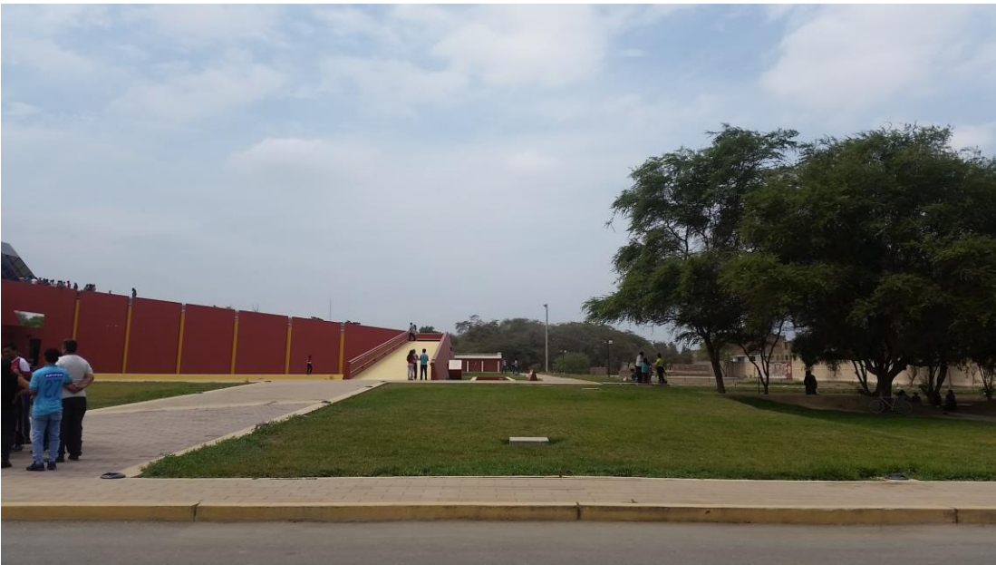
Figura 3-3: Acceso a rampa para ingresar al museo
