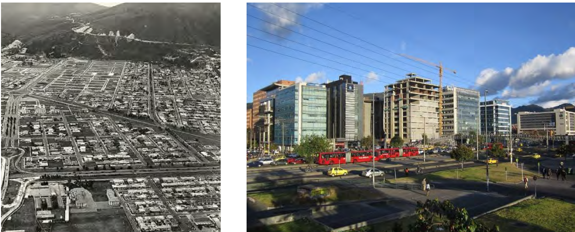
Ilustración 19 Calle 100 x Autopista Norte (Vista hacia el oriente)
