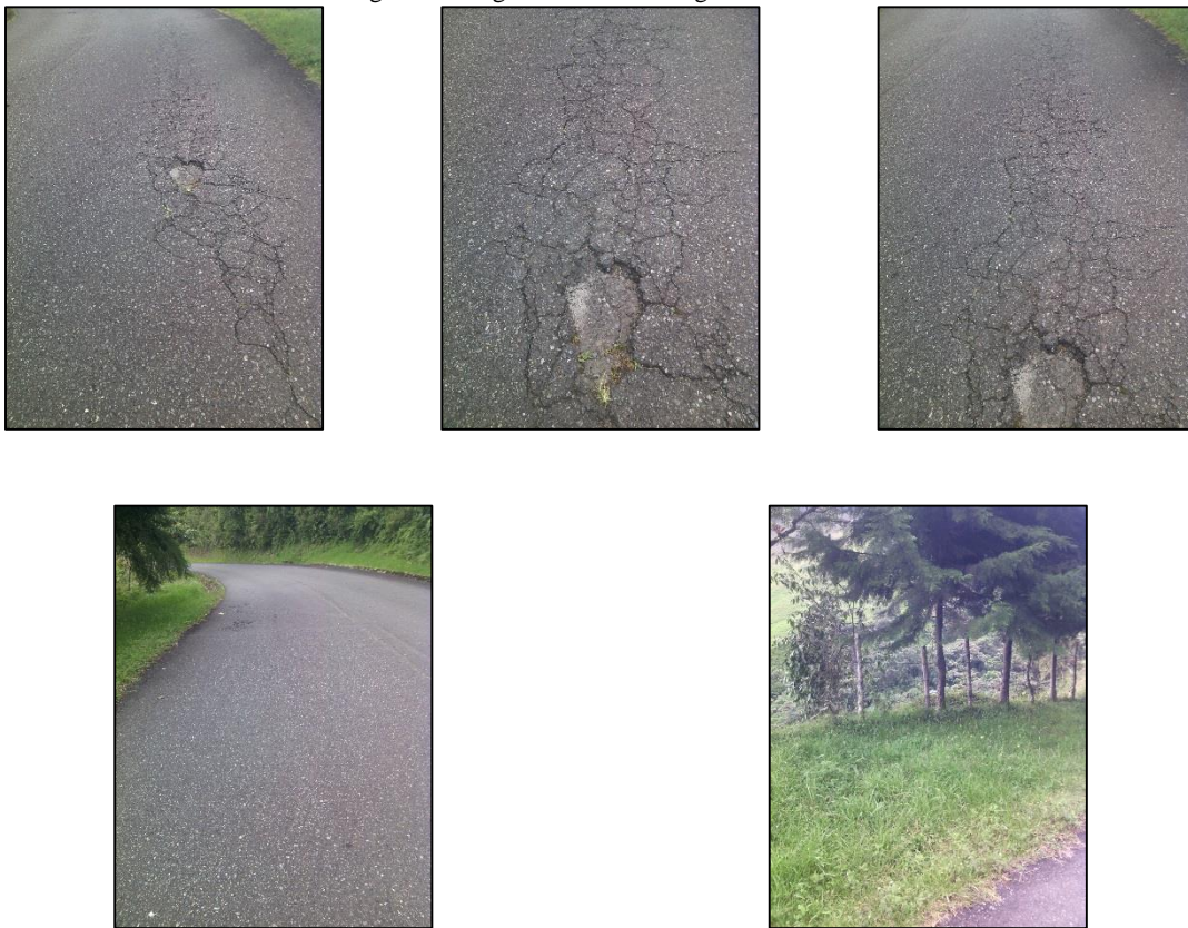
Figura 70 Fragmentos de la Antigua Vía al Mar
