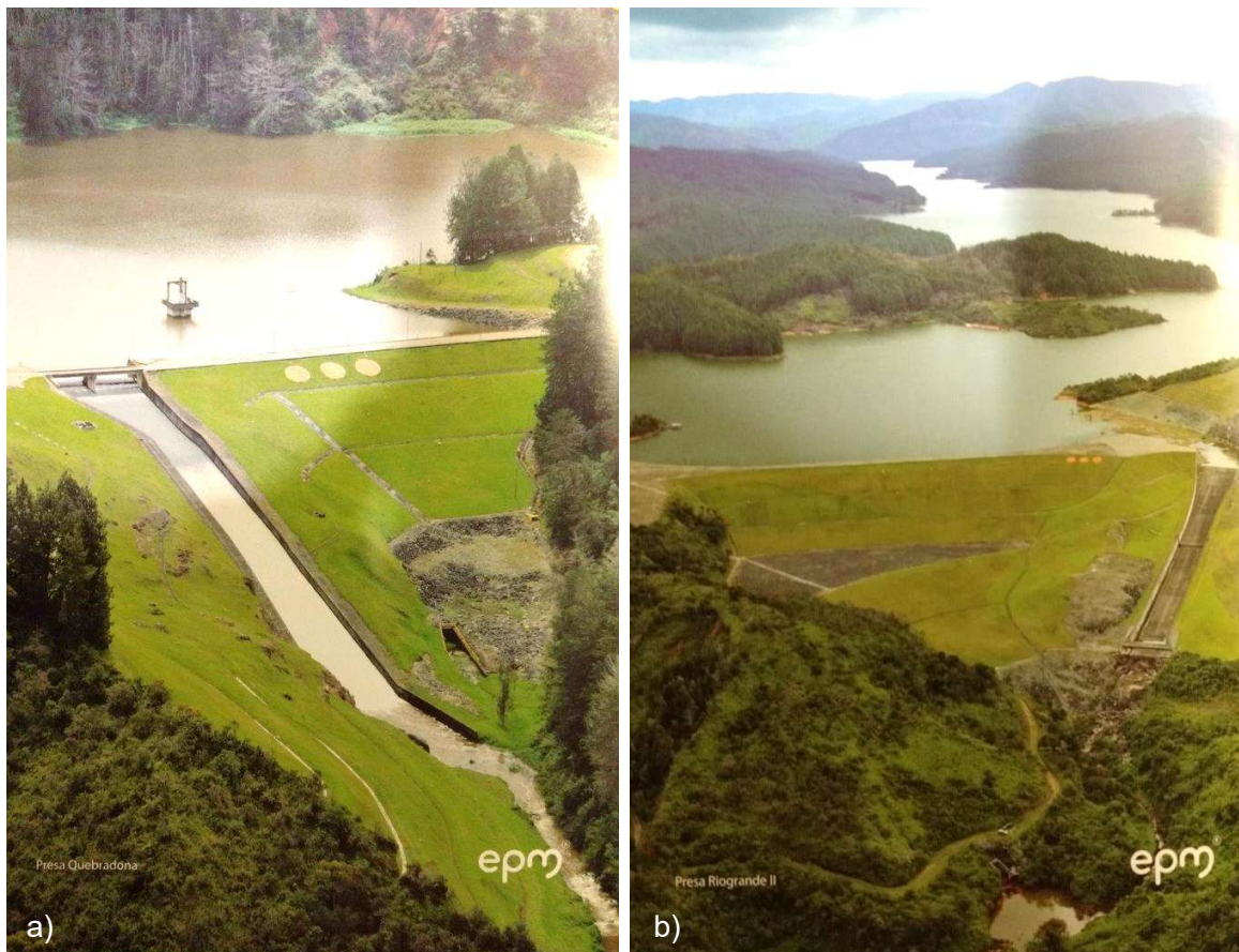
Figura 3-9: Proyectos hidroeléctricos operados por Empresas Públicas de Medellín en la cuenca del río Grande: a) Riogrande I y b) Riogrande II (Tomada de EPM, 2008).
