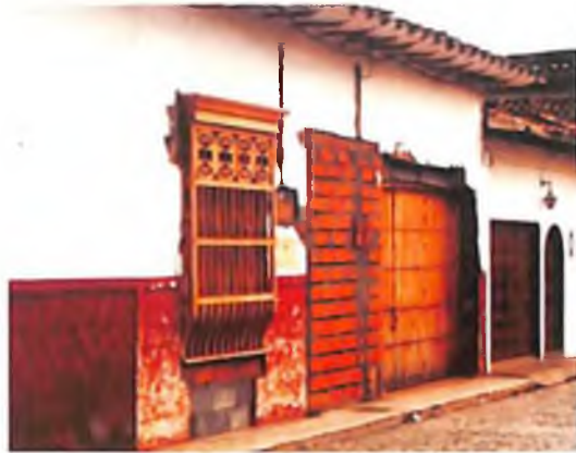
F105. Muro de tapia con agregado en ladrillo cerámico.
