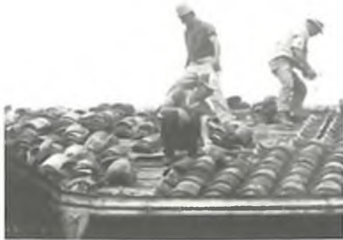
F108. El adecuado mantenimiento de una cubierta es garantía de conservación al interior de la vivienda.
