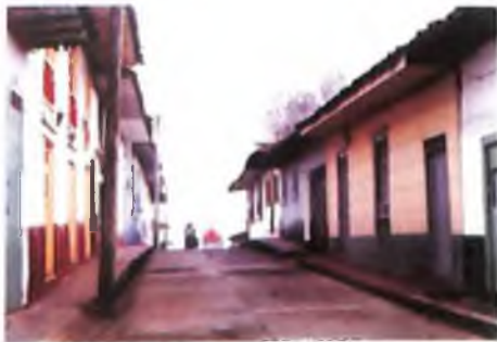
F101. El sobrepeso causa daños en la estructura.
