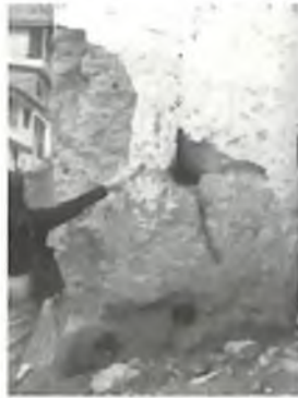
F29. Muro de tapia usado en las edificaciones, tanto al interior como al exterior.
