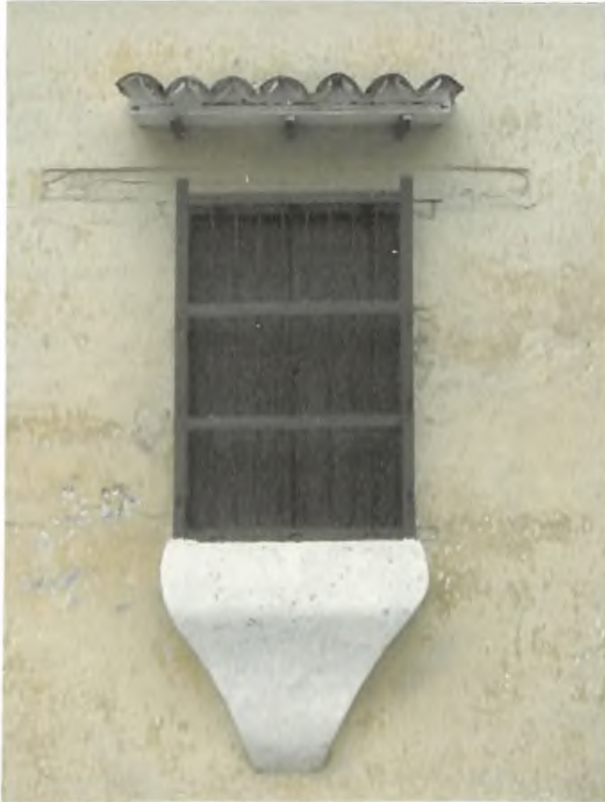
Detalle de vivienda
