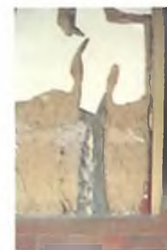
F75. Muro de tapia pisada "canchado" para instalar las nuevas tuberías eléctricas.
