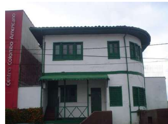
42. Sistema constructivo bahareque de transición. Casa Vásquez. 1940 - CONSERVADA
