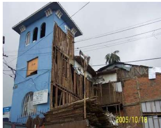
41. Sistema constructivo bahareque de transición. Clínica Manizales. 1946 – DEMOLIDA 2009
