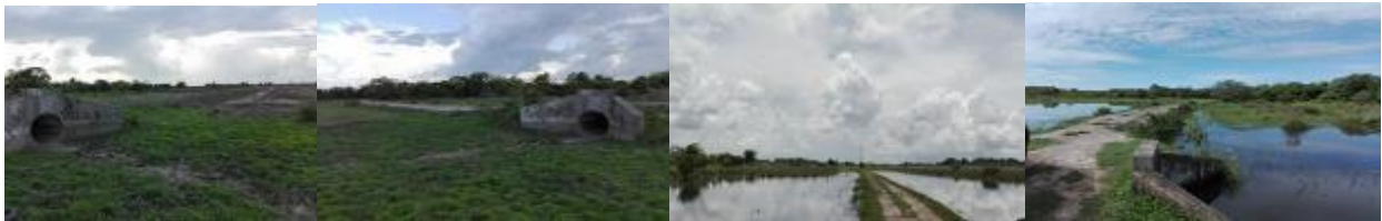
Figura 14. Terraplén o “lomo de perro” con desagüe, para el manejo y control del agua en la sabana inundable
