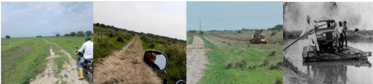
Los carretables que en número y extensión superan a la red terciaria, son a veces habilitados con mantenimiento de la motoniveladora municipal o departamental, que ofrece sus servicios a la comunidad para facilitar el tránsito vehicular en la estación seca. Fotografía M Zapata
