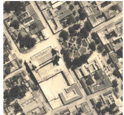
F. 121 Colegio, Iglesia San José y parque del Centenario. Foto Scdata 1938
