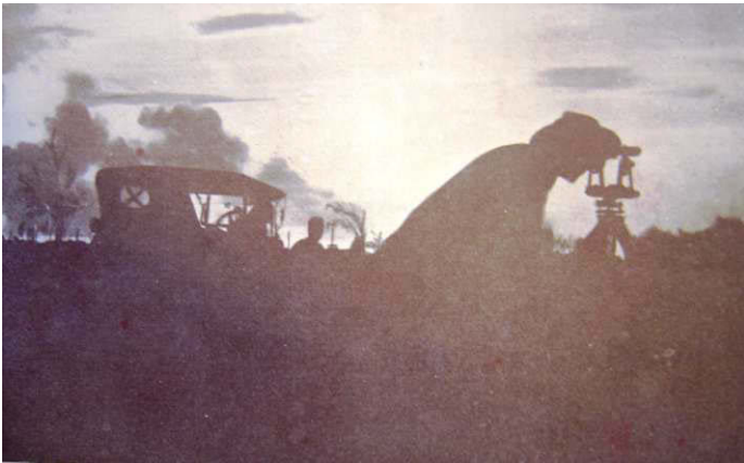
F. 49 Ing. Weirick de la empresa Parrish y cia. haciendo trabajo de agrimensura en la urbanización el Prado.
