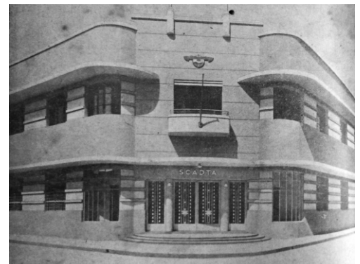
F. 195 Acceso edificio Scadta. Fuente: Mejoras n.º18, 1937.
