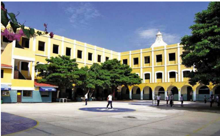
F. 120 Claustro Colegio San José. Fuente: Comunicaciones Instituto San José
