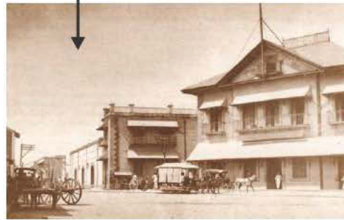
F. 31 Estación Montoya, Ferrocarril de Colombia. Vergara y Baena, 1922.
