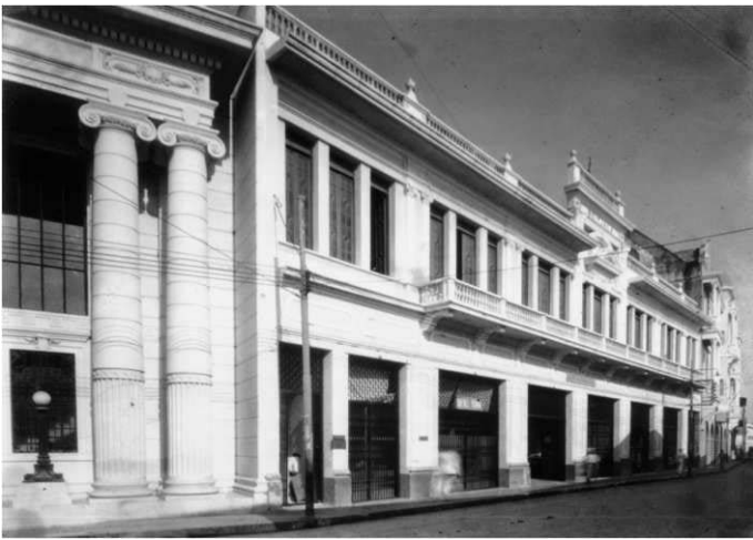
F. 184 Edificio Beitjala.
