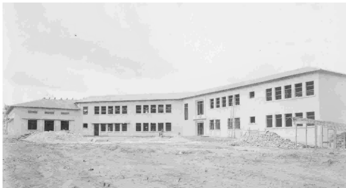
F. 114 Colegio Karl Parrish en construcción. 1945 Fuente: Filiberto Mancini
