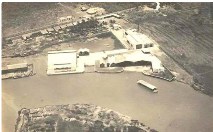
F. 26 Hidropuerto de Veranillo, foto aérea, 1928. Fuente: Scdata.co /27/10/2012.
