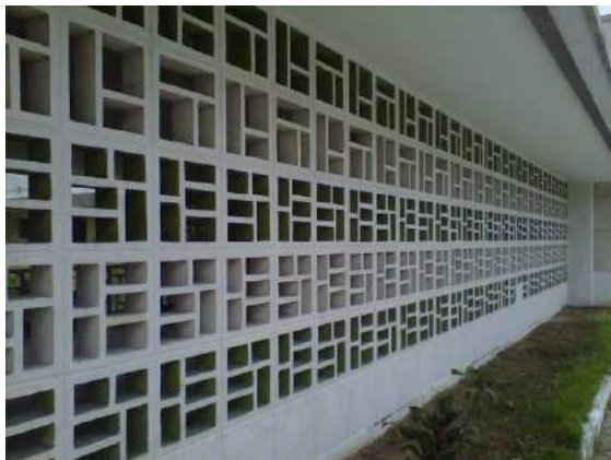
F.411 Calados en las fachadas. Foto del autor
