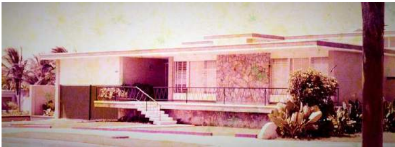
F.466 Casa en alto Prado (1955) Foto: Arq. Roberto Dugand
