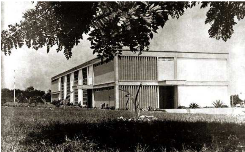
F.400. Aulas del High school. Fuente: Ayres Ltda.
