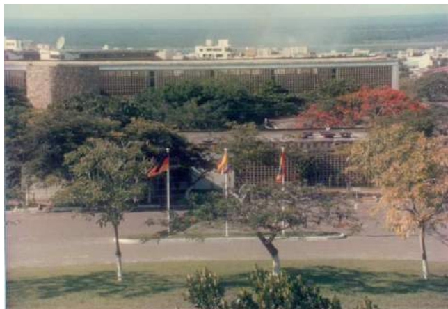
F.422 Vista fachada sur . Fuente: Ricardo Franco
