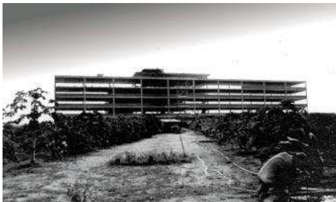
F.405 Estructura en construcción. 1959 Fuente: Ayres ltda
