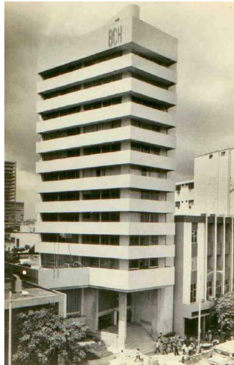
F. 325 Banco Central Hipotecario. Arq. Manuel de Andreis. Fuente: Inar Ltda
