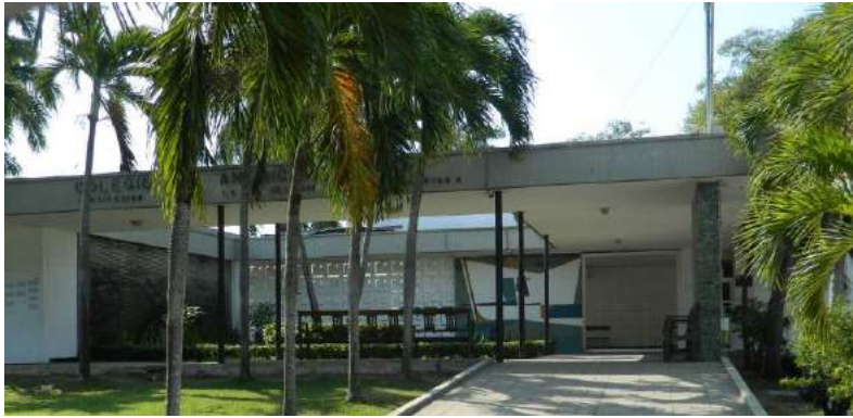
F.431 Acceso al colegio. Foto del autor
