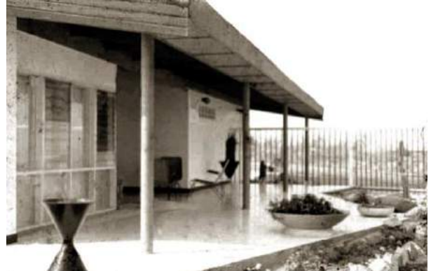
F.444 Vista a Jardín, casa en Ciudad Jardín Foto: Arq. Roberto Dugand
