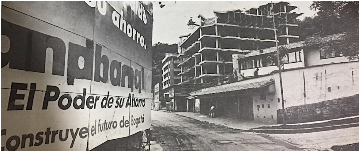
Figura 5-11. Valla de la corporación Granahorrar en un proyecto en construcción
