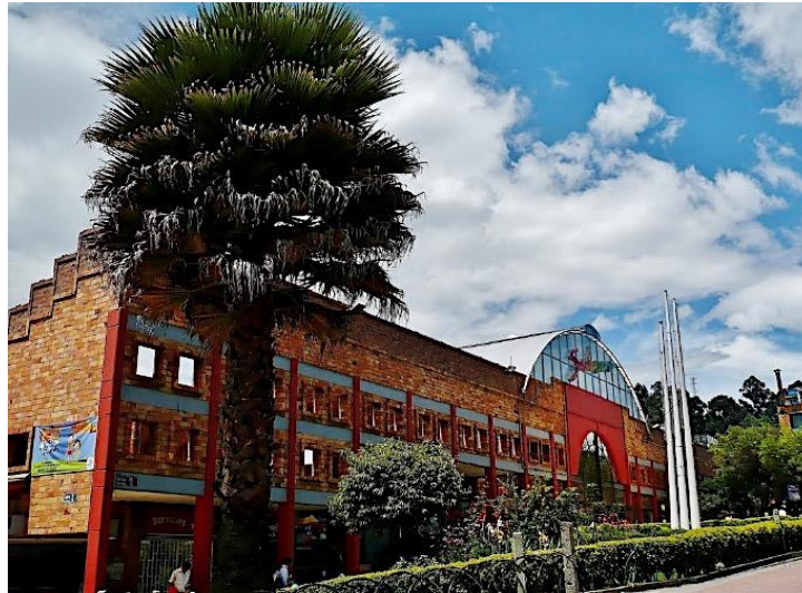
Figura 5- 23. Centro Comercial Subazar, 1990
