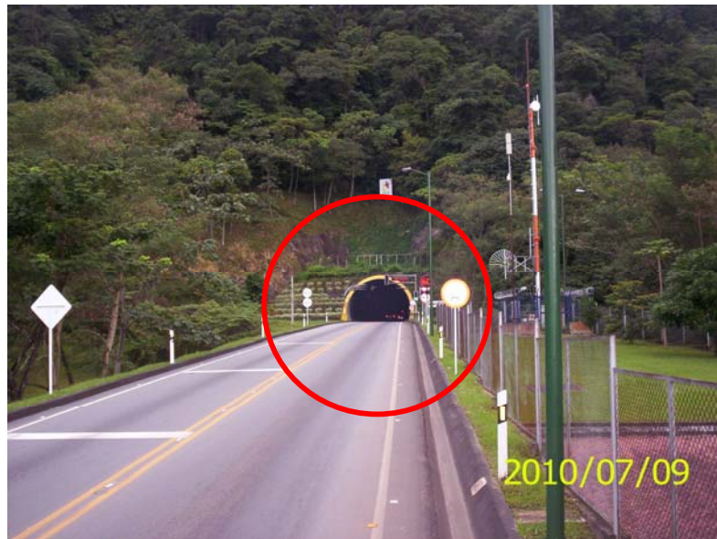
Figura 15. Vista del portal Trapiche desde la distancia (DS) del luminancímetro respectivo.
