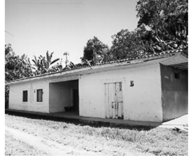
ESTACIÓN PUERTO COLOMBIA – KM 41
