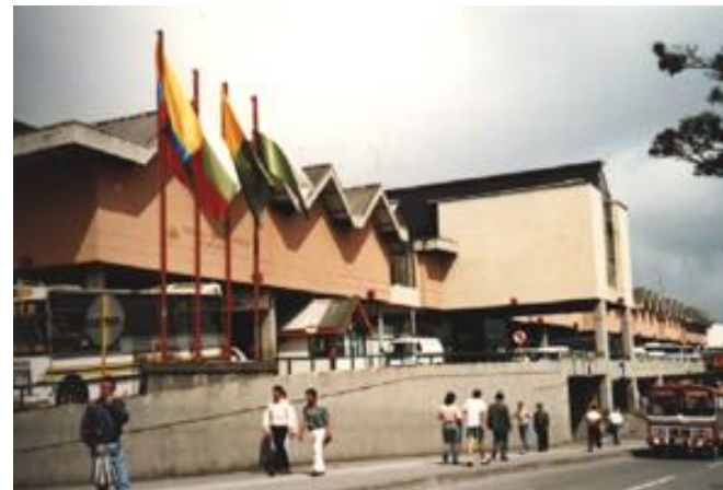
TERMINAL DE TRANSPORTE – 1.988
