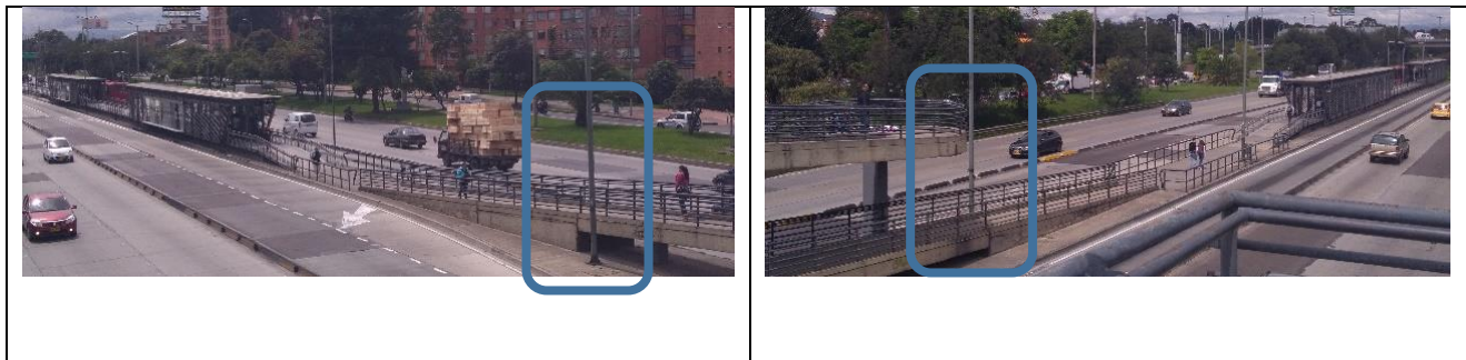
Figura 4-2: Ubicación de cámaras de video toma de ingreso peatonal costado sur y costado norte Estación BRT Mazurén
