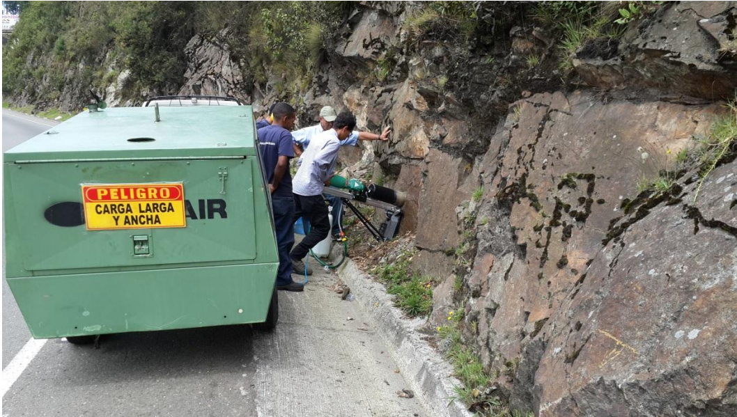
Foto 2-4: Instrumentos de trabajo en operación (compresor, taladro y bomba de agua).
