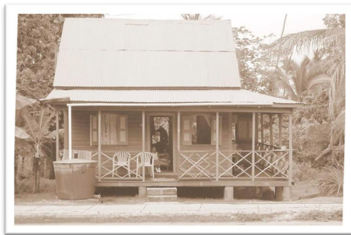
Fotografía 8. Vivienda típica isleña del sector de La Loma, donde se observa el canal para la recolección de agua lluvia, que se almacena en un tanque plástico.
