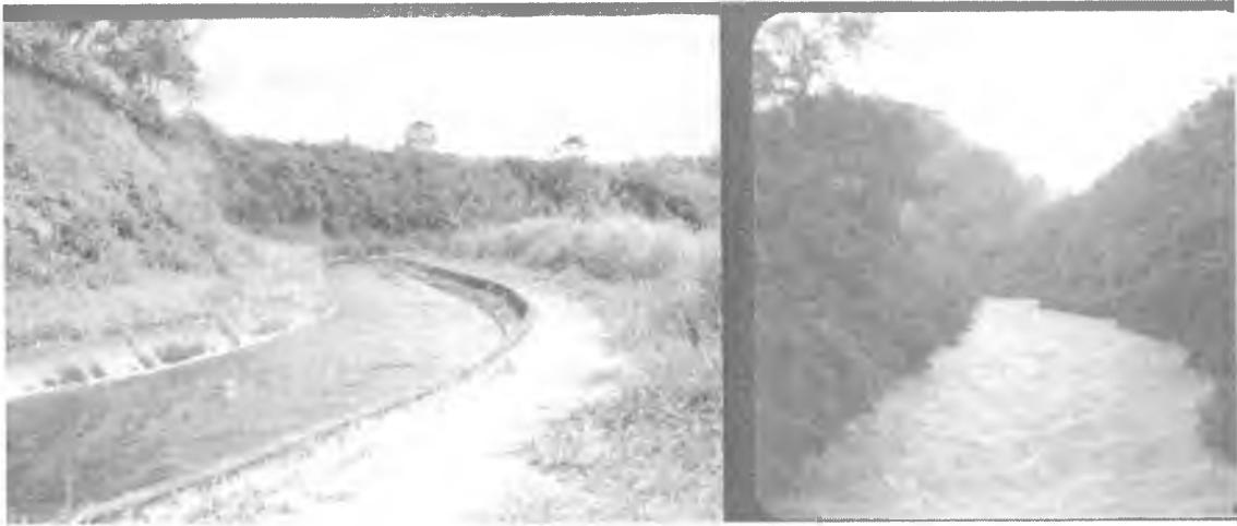
FOTOGRAFÍA 1. FLUJO PERMANENTE (CANAL) Y FLUJO NO PERMANENTE (CRECIENTE DE UN RÍO).
