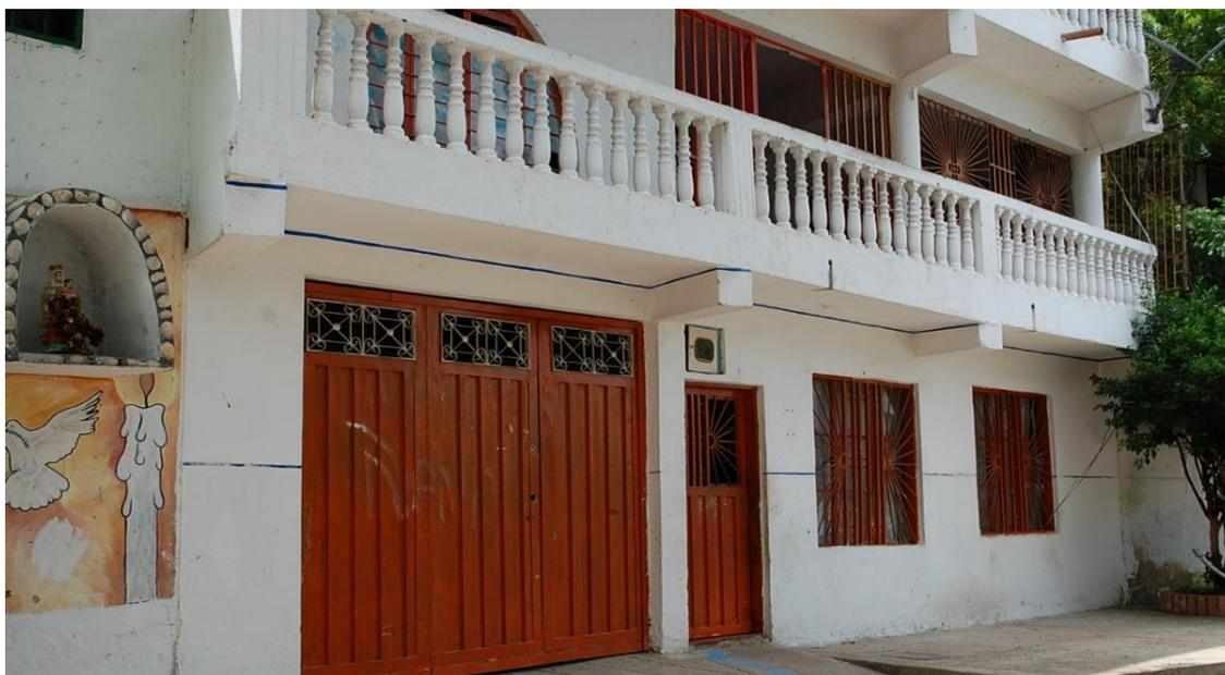
Fotografía 27. Registro de las alturas alcanzadas por el nivel del agua durante las inundaciones en 2008 y 2011 respectivamente, marcadas por una línea azul.
