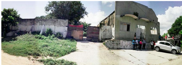
Imagen 16. Ruinas del antiguo matadero público de Soledad, Atlántico antes de ser demolido. 2016.
