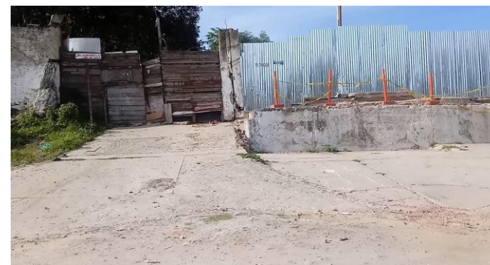
Imagen 19. Predio donde se ubicaba el antiguo matadero público de Soledad, Atlántico después de la demolición de sus ruinas. 2019.
