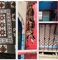
**Pág. 51.** Imagen 64: Fotos de la fachada principal, se aprecia la deformación de la portada principal en ladrillo de la casa colindante por el costado norte, este posible asentamiento genera el movimiento tanto de la fachada como del muro norte colindante de la casa de la cuarta, se evidencia en las fisuras en la parte superior de la fachada y en el muro por el costado interior. Foto. S. Rojas 2019.
