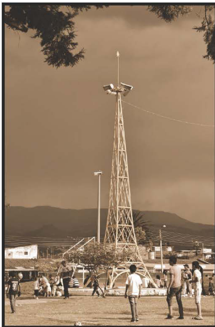
Fig. N° 7. Torre ubicada en el parque central del barrio Los libertadores.
