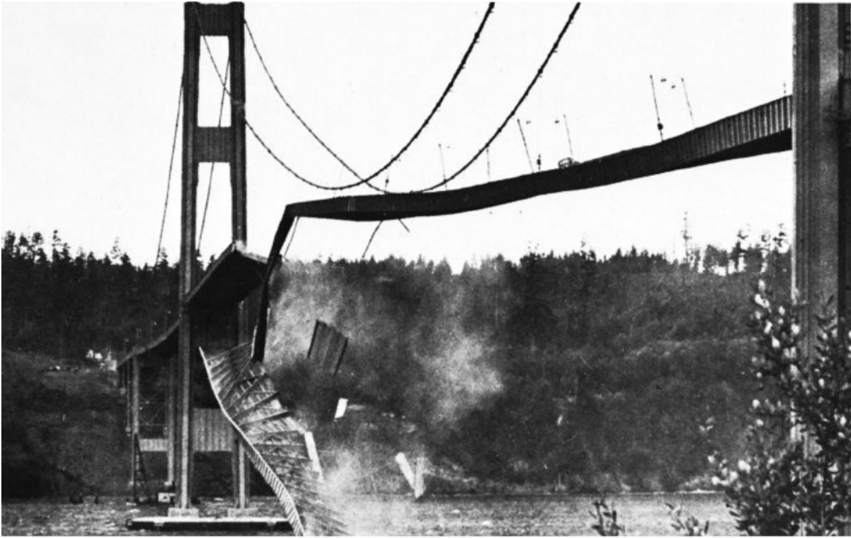
Fig. 3-1.: Puente de Tacoma durante la vibración inducida por el viento. Noviembre 7 de 1940. Imagen de Historical Photography Collection , Universidad de Washington (Rao, 2011).
