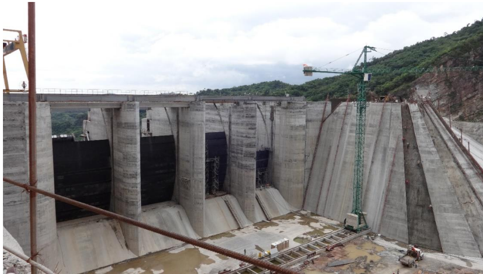
Figura 4-12: Represa Hidrosogamoso en construcción (2014)
