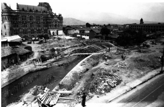
Gráfico 21 Canalización de la Quebrada Santa Elena en los años 30. Fuente: (Alcaldía Medellín, Departamento Administrativo de Planeación, 2011)
