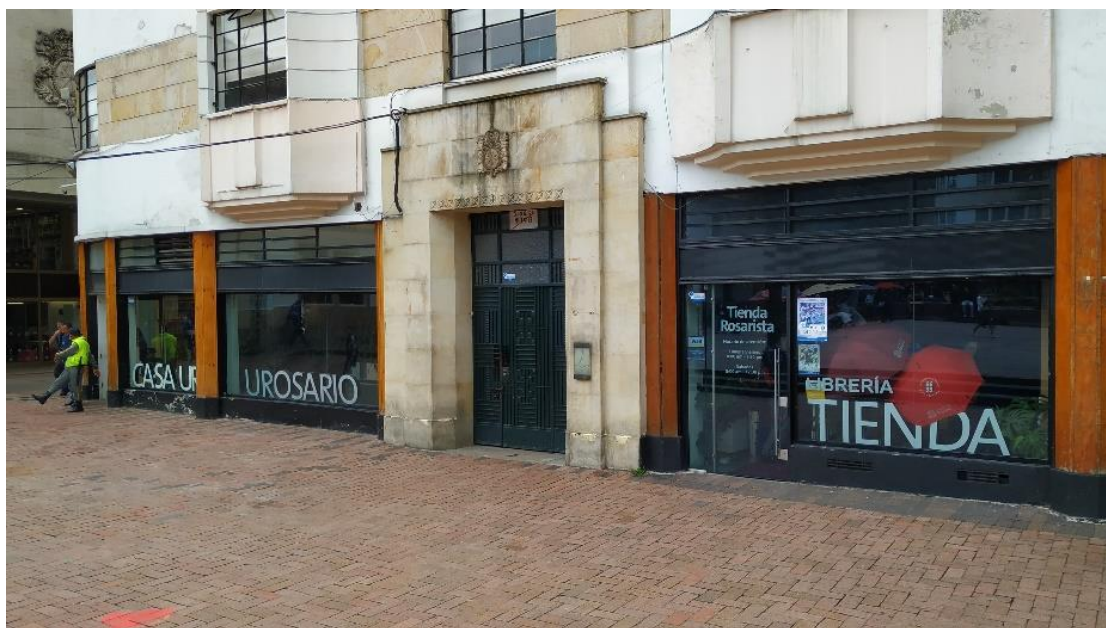
Figura 80. Conjunto Rosario, edificio Santa Fe.
