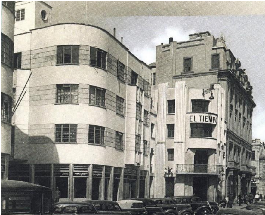
Figura 23. Edificio del diario El Tiempo y el Pasaje Santa Fe, el edificio del diario será demolido y el pasaje mutilado.
