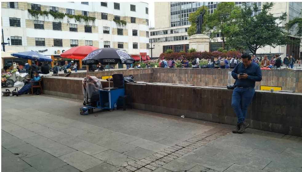
Figura 56. Muro del sótano.
