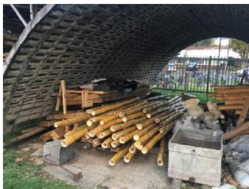
Figura 4-5 Acopio del material. Fuente: autor.
