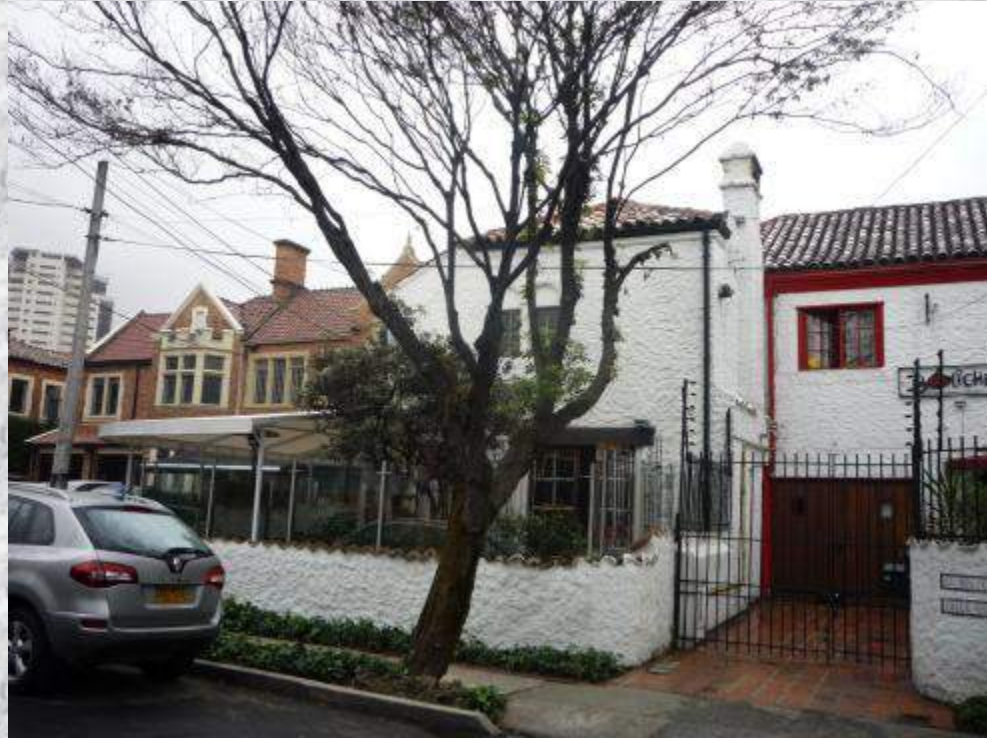
DETALLE EXTERIOR CASA MEIERHAUSEN QUINTA CAMACHO
