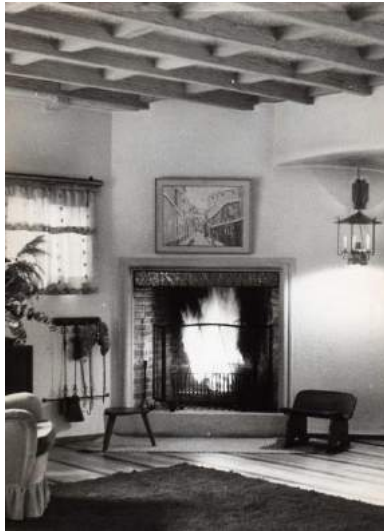
Figura 3-68: Fotografía Detalle espacio interior sala, con estructura de cielorraso en madera.
