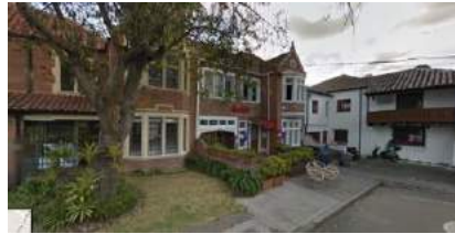
Figura 3-12: Fotografía costado sur de la manzana toma 3
