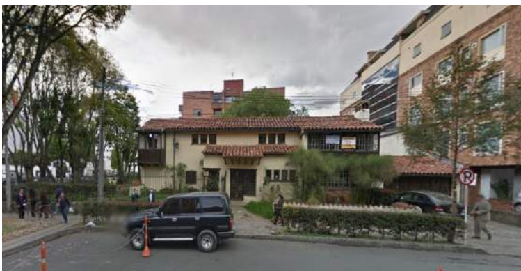
Figura 3-35: Fotografía costado occidental de la manzana toma 1
