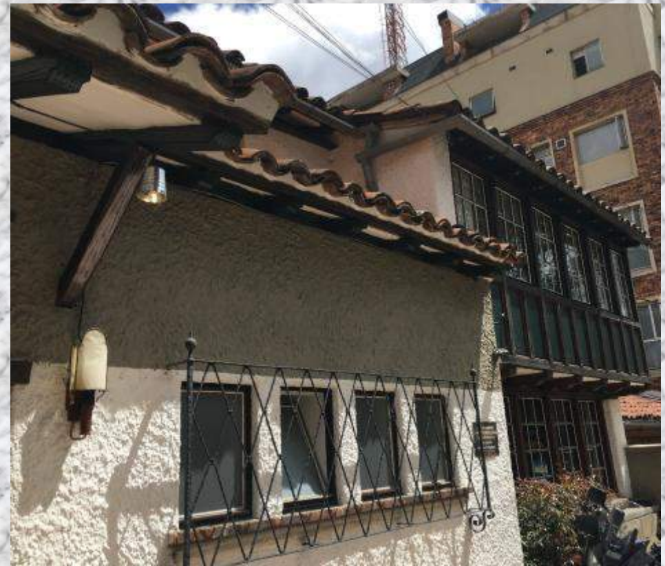
DETALLE EXTERIOR CASA CORREAL CHICO
