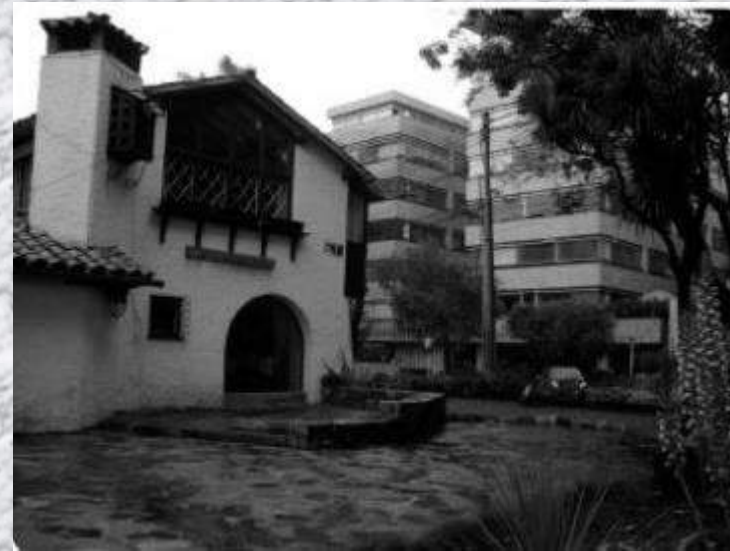
FACHADA CASA CORREAL CHICO
