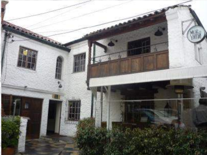
FACHADA CASA MEIRHAUSEN QUINTA CAMACHO
