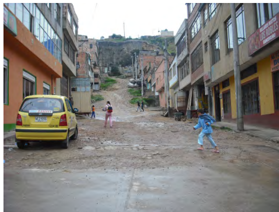
Imagen 30. Estado de las vías en el sector Canteras
