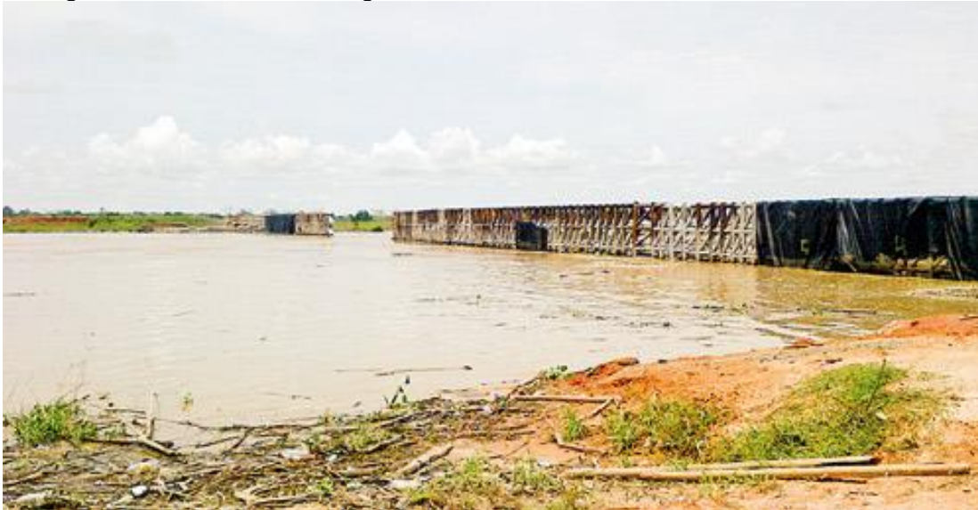
Fotografía 3-4: Intervención ingenieril en el chorro Santa Anita, San Marcos, Sucre.
