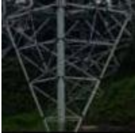
Figura 187. Pata de una torre
