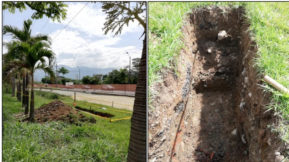
Figura 4-55. Trincheras excavadas para ensayo en Distribuidora de Envigado.
