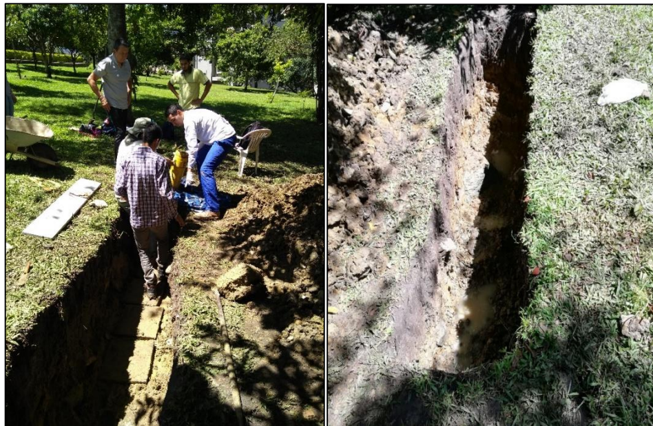
Figura 4-62. Trinchera excavada para ensayo en Finca Las Mercedes.
