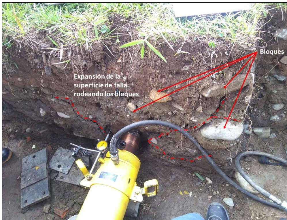
Figura 4-58. Evidencia de la tortuosidad de la superficie de falla – E1 – Distribuidora de Envigado. Elaboración propia.
