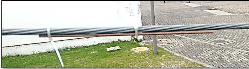
Figura 2-8 Imagen de la fijación de un sensor FBG sobre la línea.
