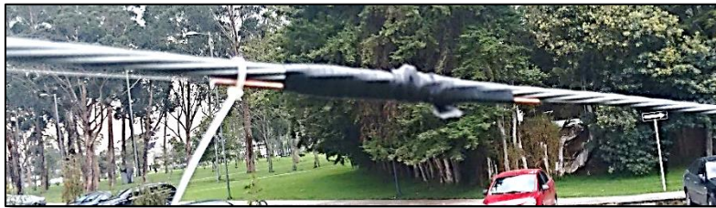
Figura 2-9 Imagen de la fijación y recubrimiento del sensor FBG1
