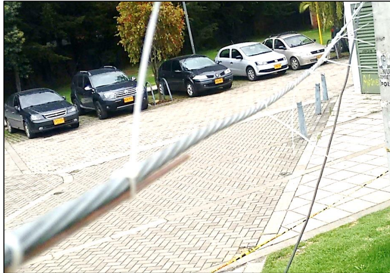
Figura 2-10 Imagen de la fijación de la fibra con amarres a separaciones regulares
