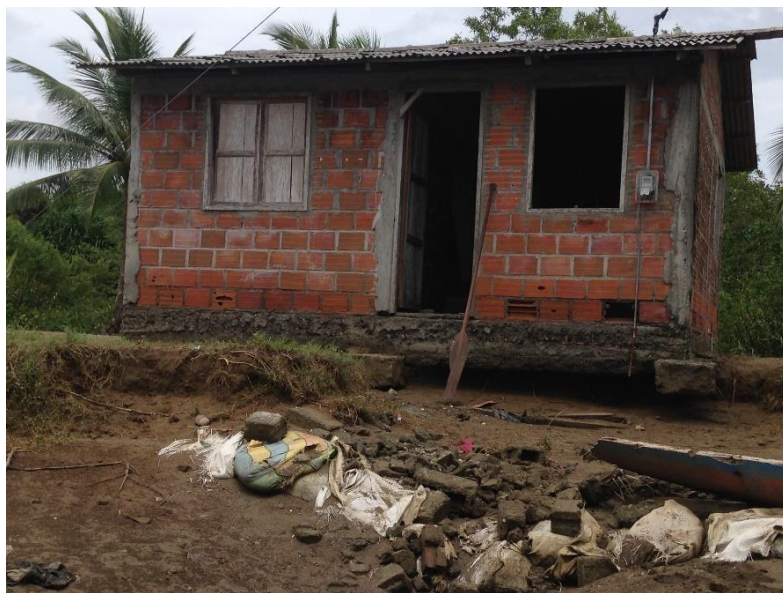
Figura 12. Caso de pérdida de suelo debido a la erosión en Jurubidá. Relleno con piedra y arena como medida para reducir el impacto de la erosión
