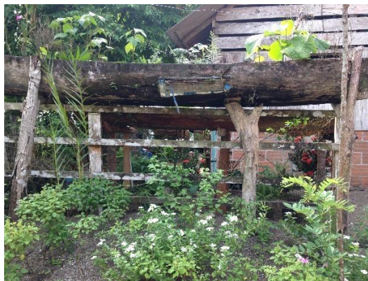
5. Ampliación de vivienda con segunda planta por afectación de inundaciones. Cambio de materiales más resistentes a los vientos y a las lluvias.
