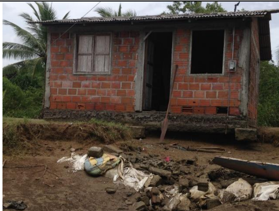
8. Construcción con materiales más resistentes al oleaje
