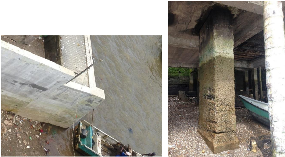
Figura 15. Marca de agua debido al ascenso del río Guapi
